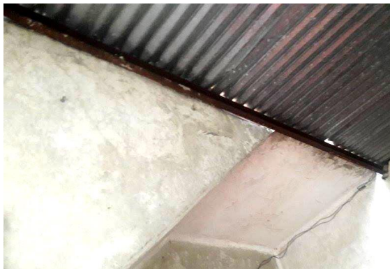
ANTES Techo agrietado, con presencia de óxido
