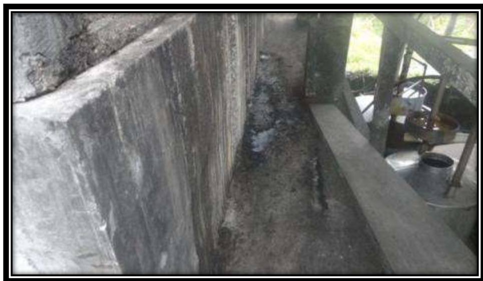
Figura N° 71: Pisos y escaleras.
