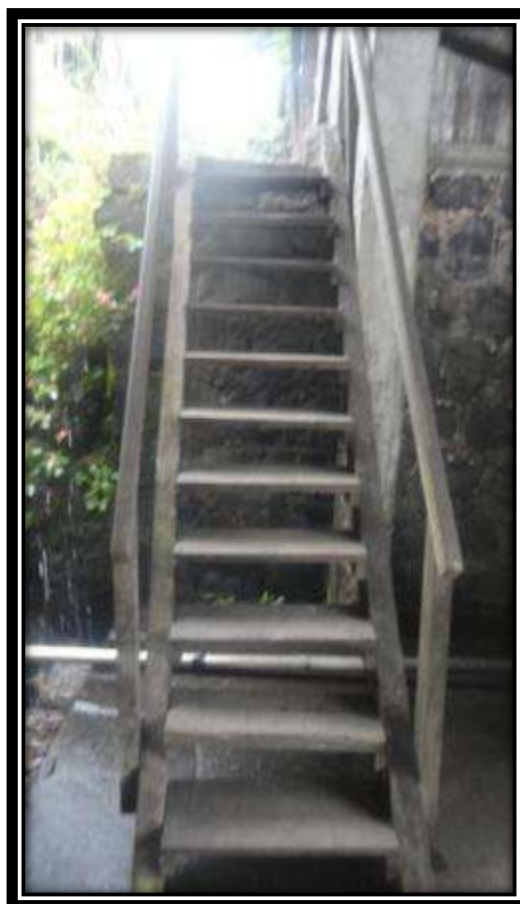
Figura N° 72: Pisos y escaleras.
