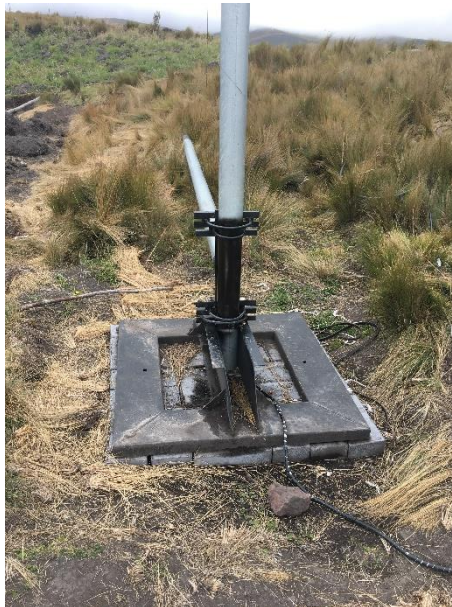
Base del aerogenerador con el colchón de adoquines
