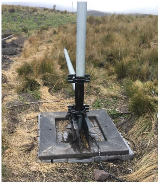
Figura 38. Colchón de adoquines cuadrados para una mejor estabilidad de la máquina [Autor].
