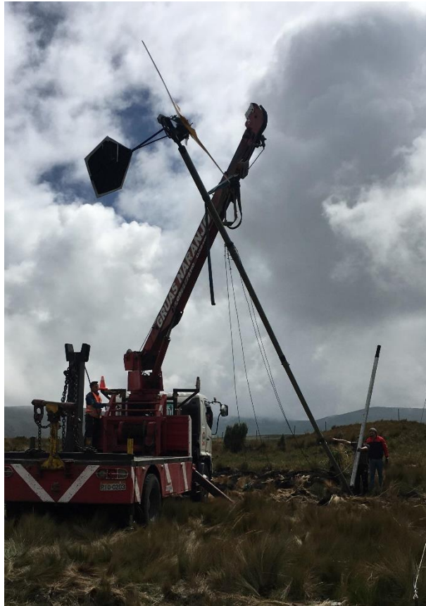
Descenso del aerogenerador con grúa
