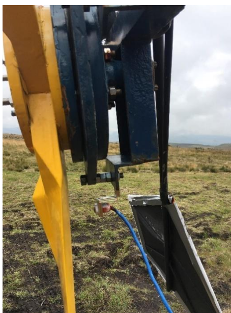
Figura 40. Instalación del sensor de rpm a la altura del buje [Autor].
