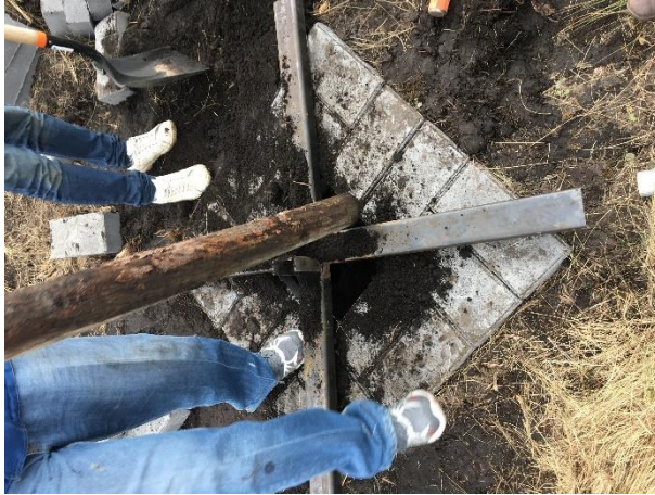
Instalación de la base articulada que soportará a la torre de muestreo
