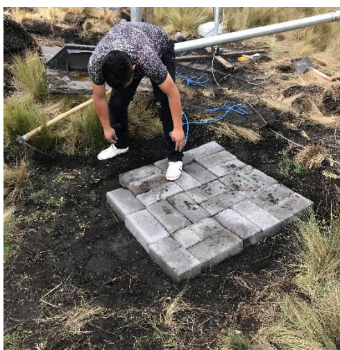
Figura 32. Colchón de adoquines cuadrados para la sustentación y estabilidad de la base meteorológica [Autor].
