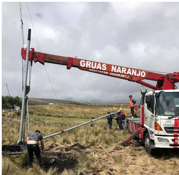
Colocación del sensor de rpm y nivelación del terreno para colocar los adoquines que formen parte de la base y la torre sea más estable.
