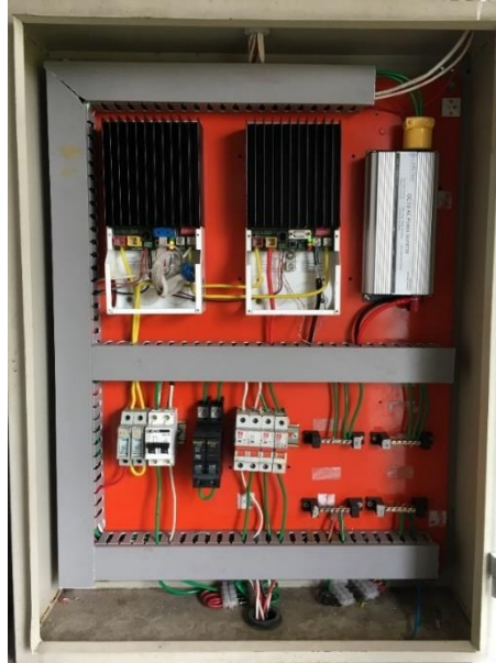
Figura 36. Reestructuración del cableado del sistema de control para realizar las mediciones [Autor].
