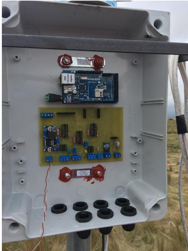
Instalación de la caja hermética que guardará el tablero de control
