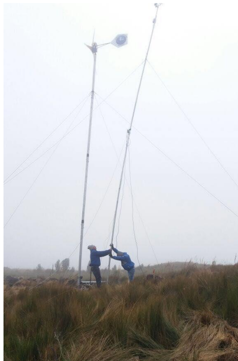
Figura 33. Levantamiento de la torre para el muestreo del aerogenerador [Autor].
