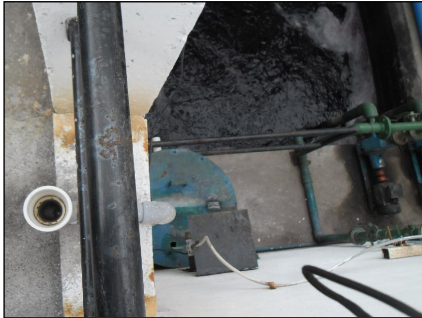
Fig. 14 TK2- Tubo para dosificar ácido sulfúrico
