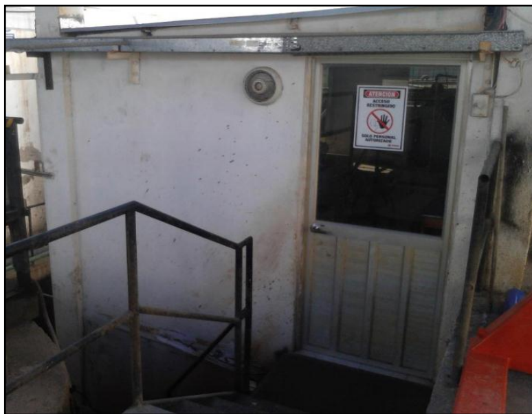
Fig. 16 Ingreso al laboratorio de la PTAR
