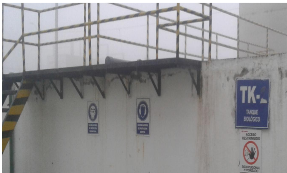
Fig. 36 Colocación de señalética en cada área de la PTAR
