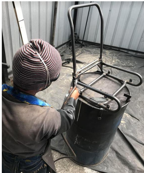
Figura 3. 16. Pintado de la estructura. Fuente: Autor
