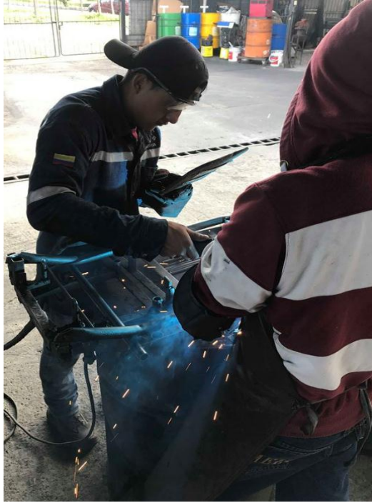
Figura 3. 13. Ensamble de la estructura. Fuente: Autor
