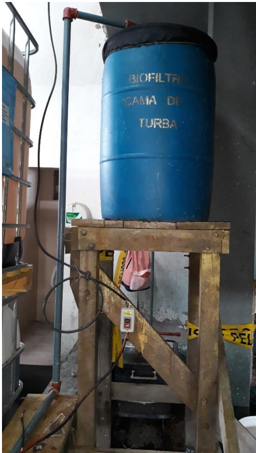
Ilustración 3. Estructura de soporte
