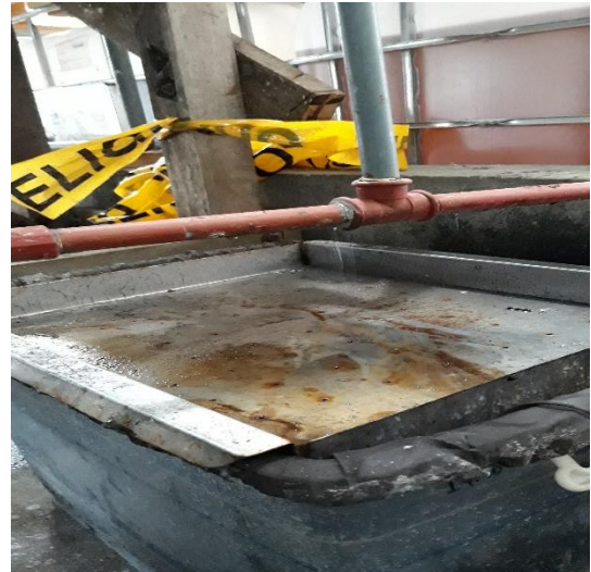
Ilustración 11. Goteo de Agua residual.
