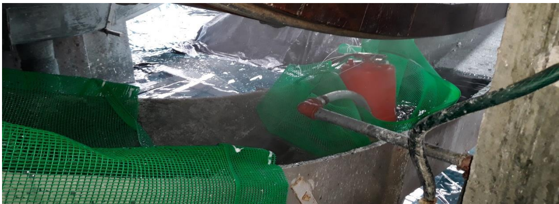
Ilustración 9. Malla y bomba ya instaladas para la recolección de Agua Residual.
