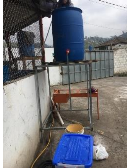
Imagen 18. Biofiltro en funcionamiento
