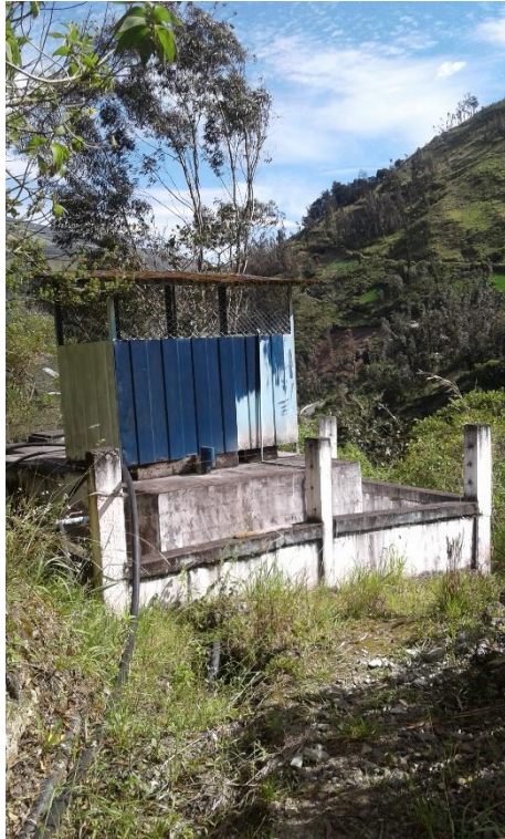
7. Tanque de almacenamiento y caseta de cloración
