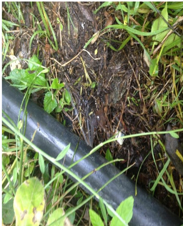
10. Red de distribución a la intemperie
