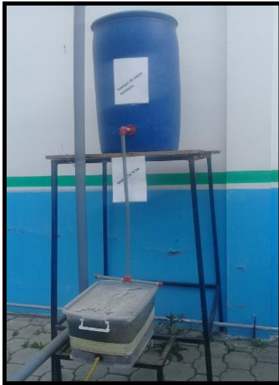
Imagen 4. Sistema filtrante concluido
