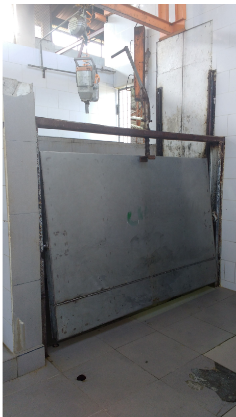
Figura 5. Cajón de aturdimiento, mostrando la puerta de ingreso tipo guillotina
