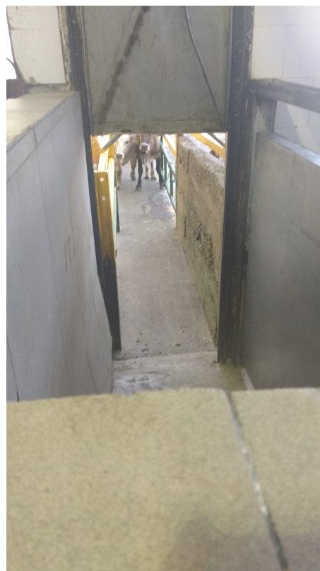
Figura 6. Vista frontal del interior del cajón, muestra la puerta de ingreso.
