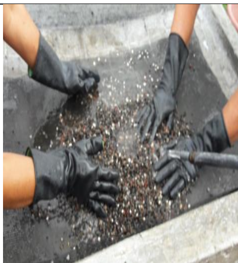
Lavado de la grava previo a la colocación en el filtro
