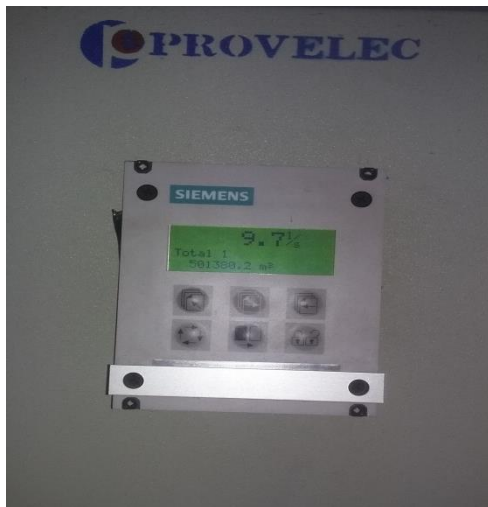
Medición de caudal de salida en el Macro Medidor a las 16:00 PM.
