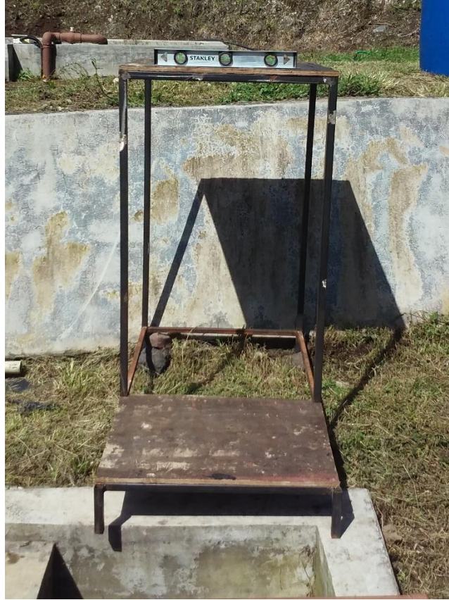
Nivelación de la estructura
