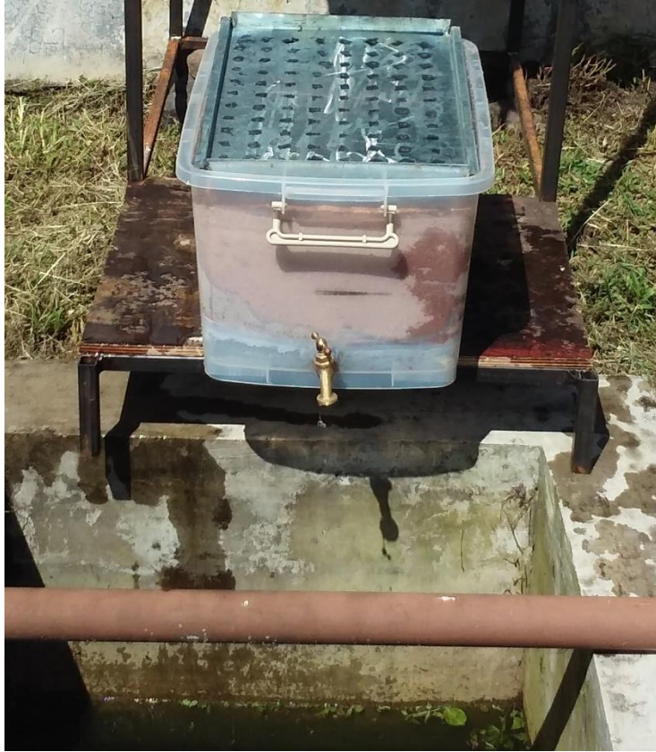
Colocación del tol difusor de agua residual.
