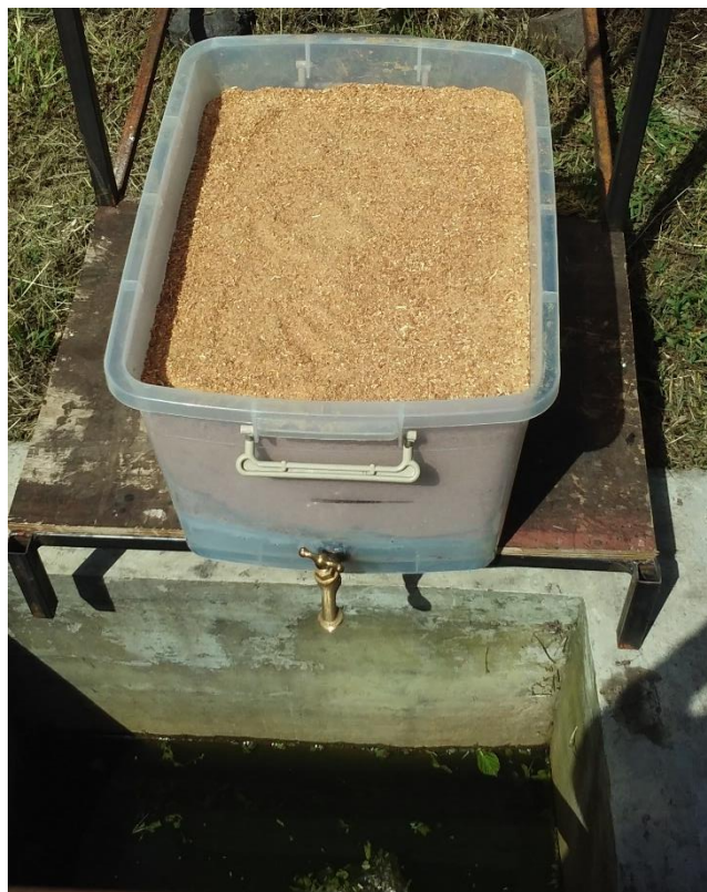
Colocación del biofiltro de aserrín de madera
