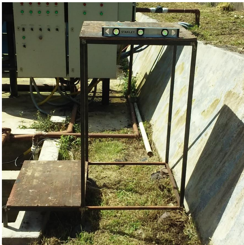
Implantación y nivelación de la estructura
