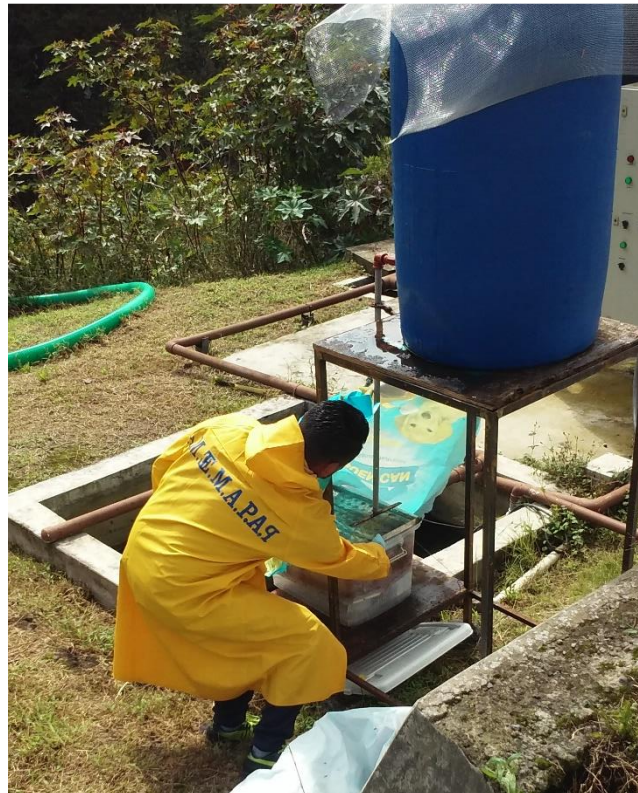
Limpeza y mantenimiento del tol difuso del agua residual
