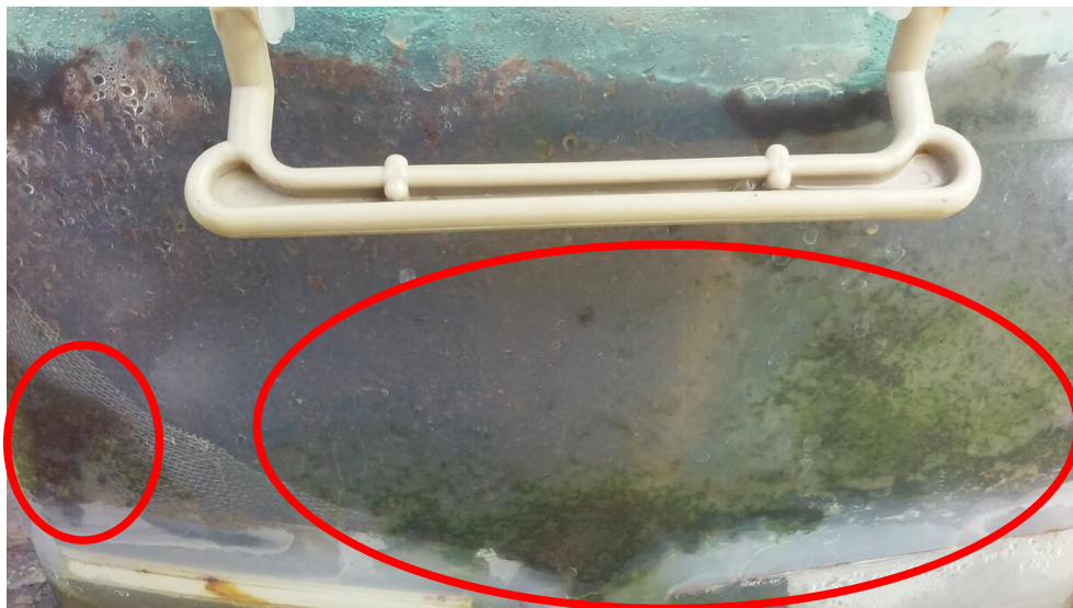
Aparición de algas en la capa inferior del biofiltro
