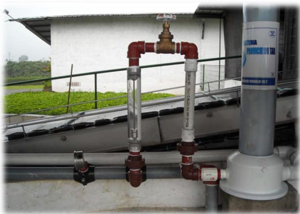
Ilustración 10 Forma de Instalación de las Tabletas de Cloro
