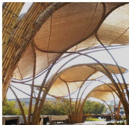
Gráfico N°7: Construcciones con caña Expo. Zaragoza 2008
