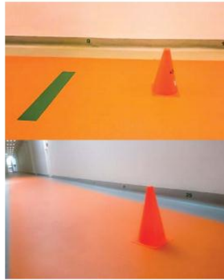
Figura 3. Conos de tráfico y marcas visibles colocadas sobre la pared.
