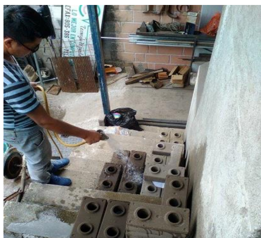
Curado de Ladrillos
