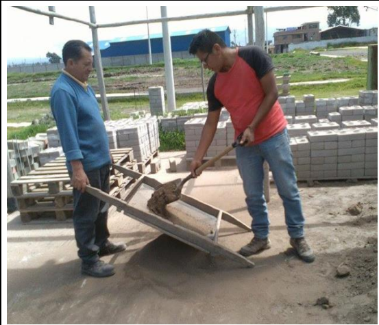
Tamizado de Material de Mezcla
