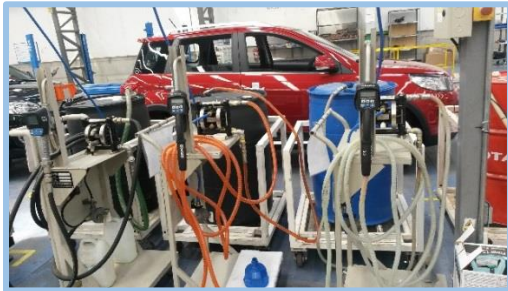
Figura 70. Mangueras para llenado de aceite y combustible
