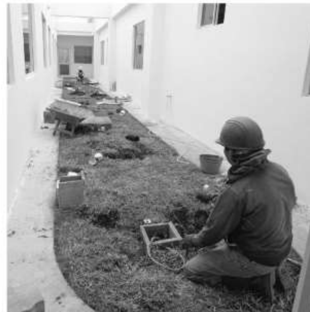
CONSTRUCCIÓN. Los trabajos continúan en varias casas de salud.
