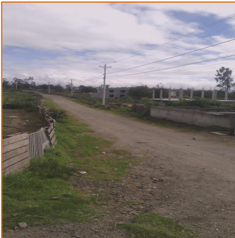
Fotografía N°02. Vía de Tierra.
