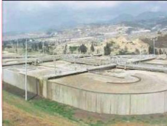
Gráfico N° 18. Zanjón de oxidación.
