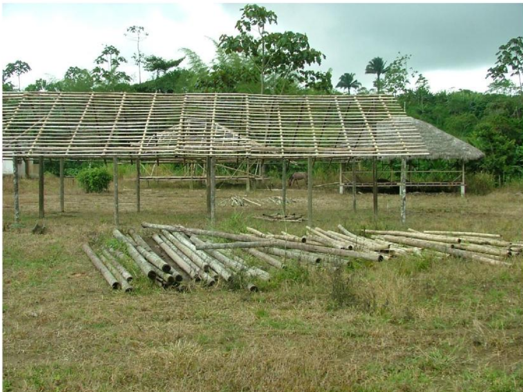
Area de cabañas y salon de reuniones en construcción
