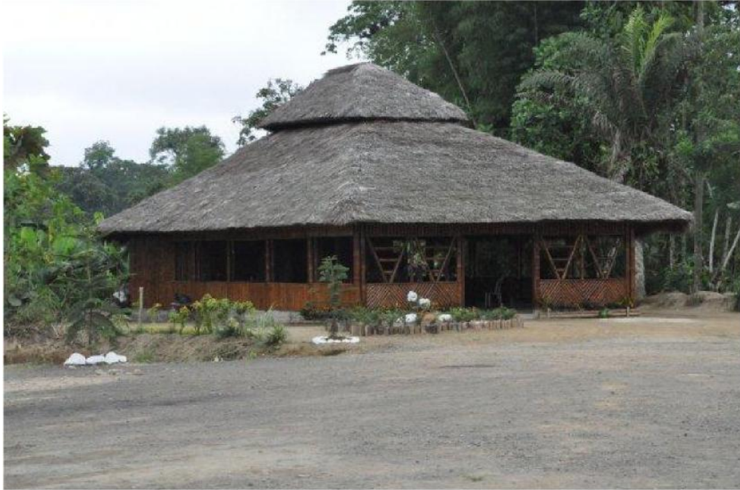
Restaurante del Centro Comunitario Tolon Pelé
