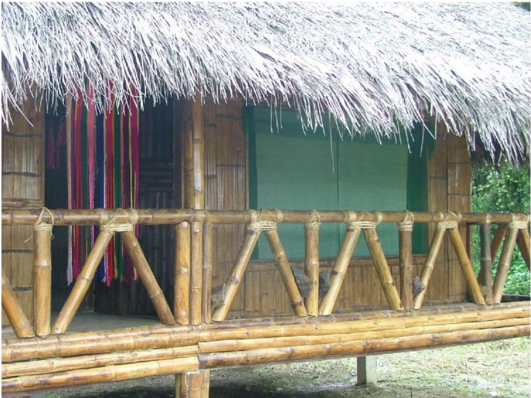
C abañas de alojamiento en proceso de construcción
