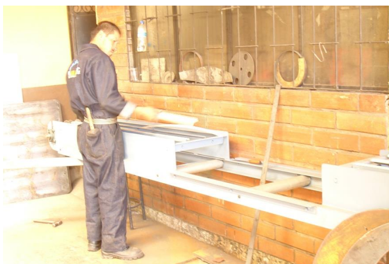
Figura 3.37 Construcción de las rampas de transporte Fuente: Autor
