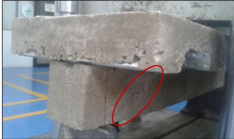
Gráfico N° 38. Fisuras en la Viga de H°A°
