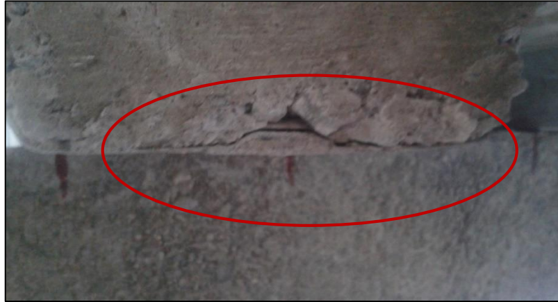
Gráfico N° 30. Pérdida de Adherencia entre la Placa Colaborante y el Hormigón
