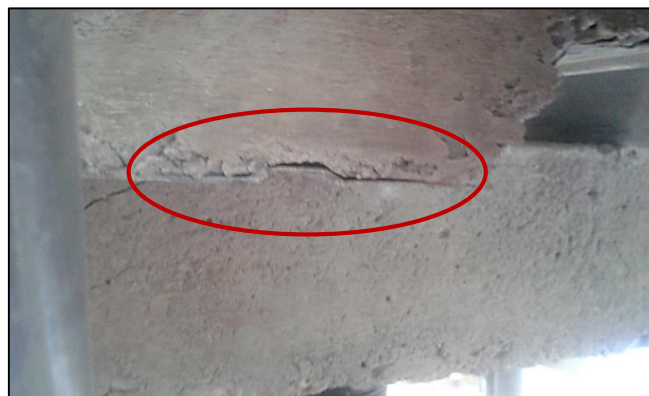
Gráfico N° 48. Pérdida de Adherencia entre la Placa Colaborante y el Hormigón
