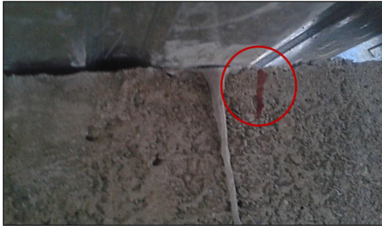
Gráfico N° 37. Desplazamiento Losa Compuesta – Viga de H°A°
