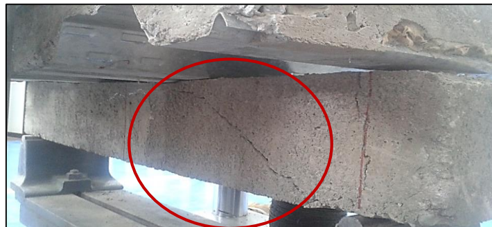
Gráfico N° 56. Fisuras en la Viga de H°A°
