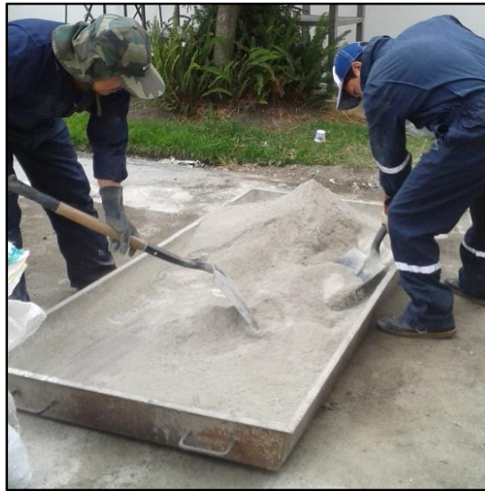
Gráfico N° 13. Mezclado de los Agregados
