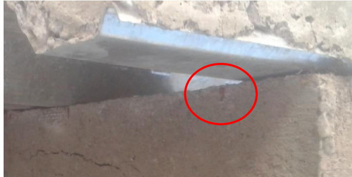
Gráfico N° 43. Desplazamiento Losa Compuesta – Viga de H°A°
