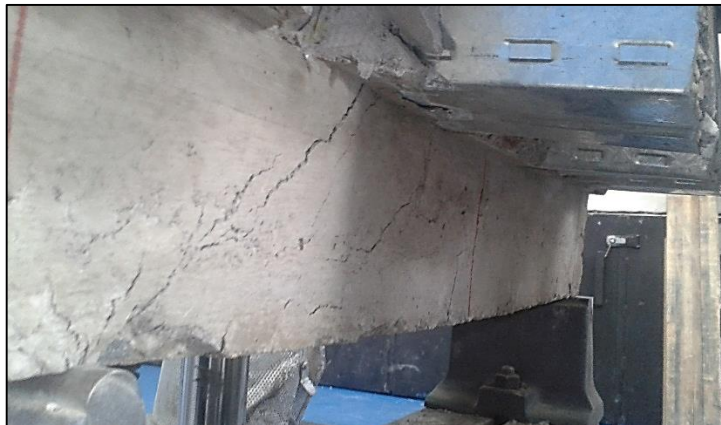
Gráfico N° 61. Fisuras en la Viga de H°A°
