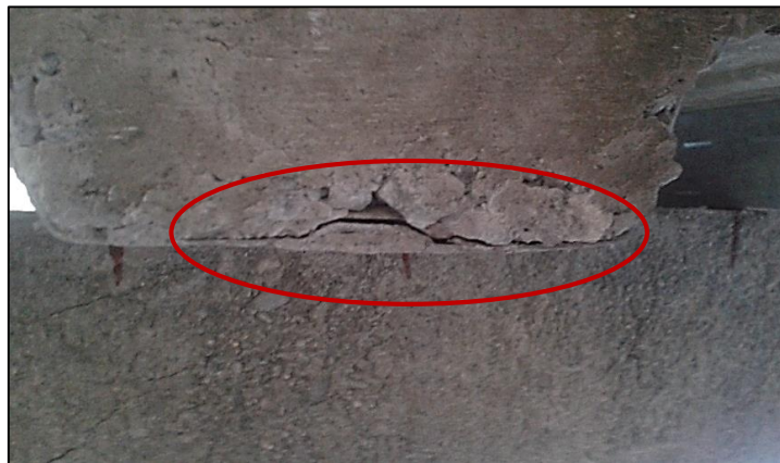
Gráfico N° 24. Pérdida de adherencia con el incremento de carga
