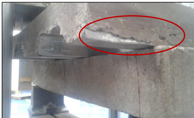
Gráfico N° 36. Pérdida de Adherencia entre la Placa Colaborante y el Hormigón
