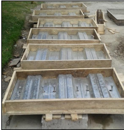
Gráfico N° 17. Encofrado de la Losa Compuesta
