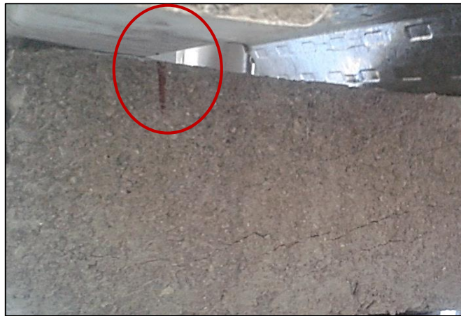
Gráfico N° 25. Desplazamiento Losa Compuesta – Viga de H°A°
