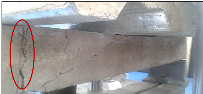
Gráfico N° 44. Fisuras en la Viga de H°A°
