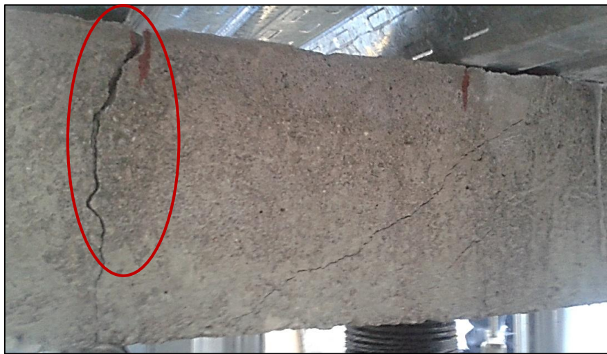
Gráfico N° 32. Fisuras en la Viga de H°A°
