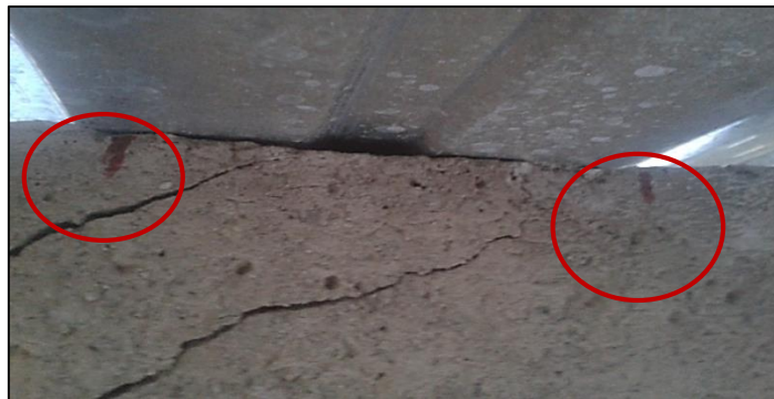
Gráfico N° 49. Desplazamiento Losa Compuesta – Viga de H°A°
