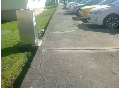
Figura 4.25 Salida de la Facultad de Jurisprudencia
