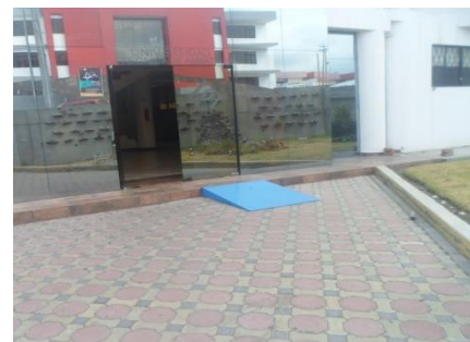
Figura 4.21 Entrada a la Biblioteca
