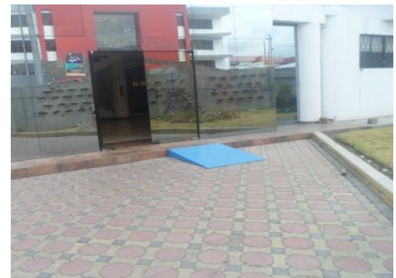
Figura 4.14 Entrada de la Biblioteca Elaborado por: El Investigador
