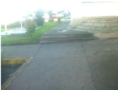
Figura 4.27 Parqueadero de la Facultad de Jurisprudencia
