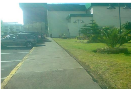
Figura 4.42 Parqueadero de la Facultad de Sistemas
