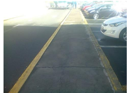
Figura 4.26 Parqueadero de la Facultad de Jurisprudencia
