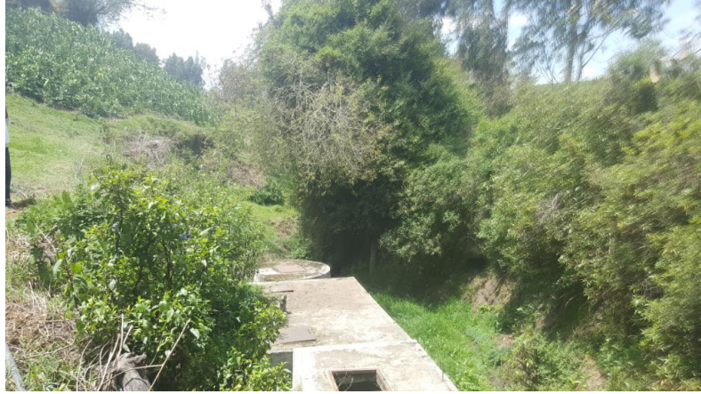
Foto 7. Planta de tratamiento que no está en funcionamiento
