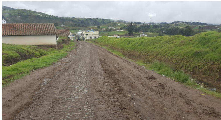
Foto 8. Vía por donde ira el Alcantarillado
