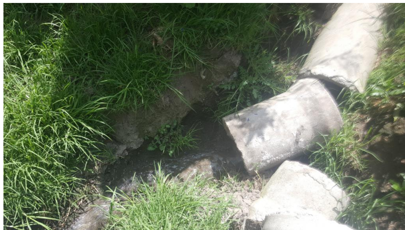
Foto 6. Descarga del alcantarillado existente
