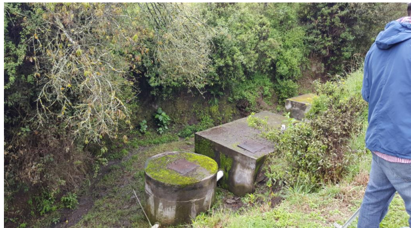
Foto 12. Planta de tratamiento que no está en funcionamiento
