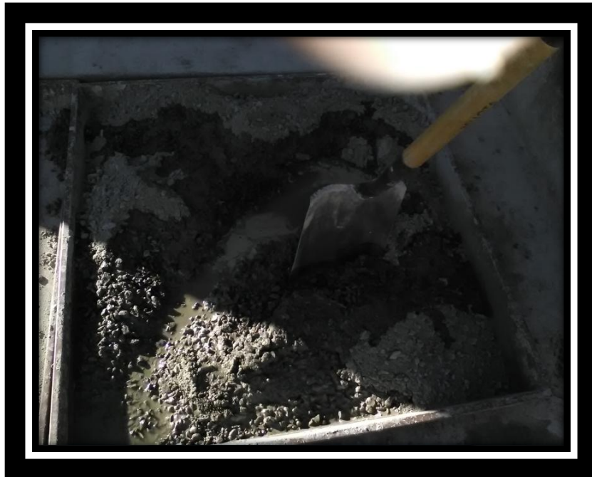
Mezcla del hormigón
