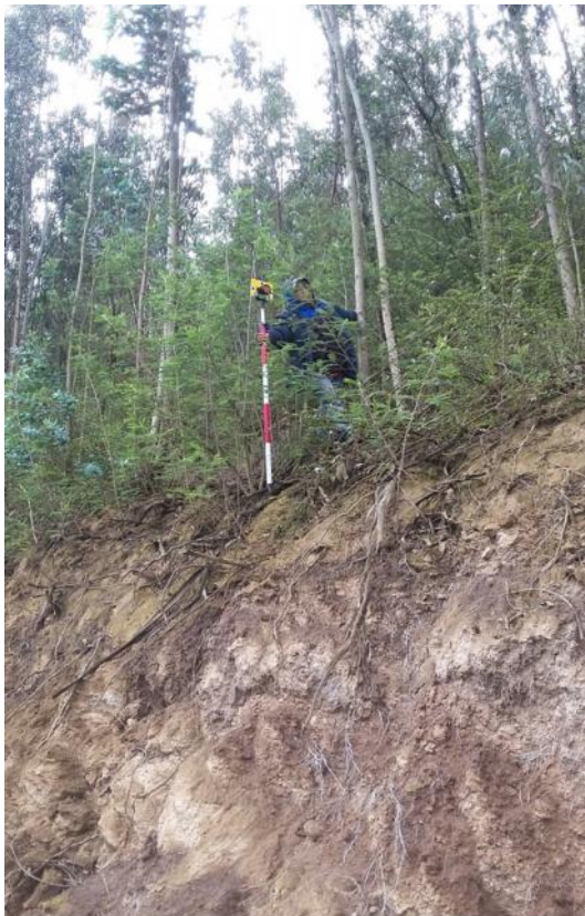
Punto topográfico ( talud superior)
