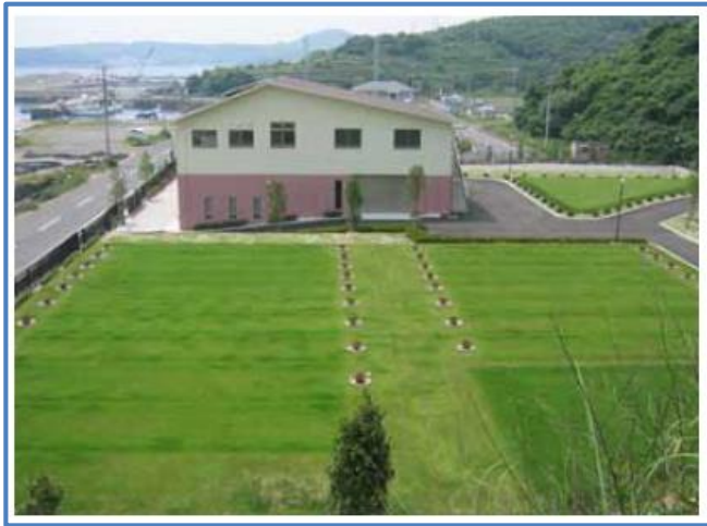
Figura 8: Planta de tratamiento terminada
