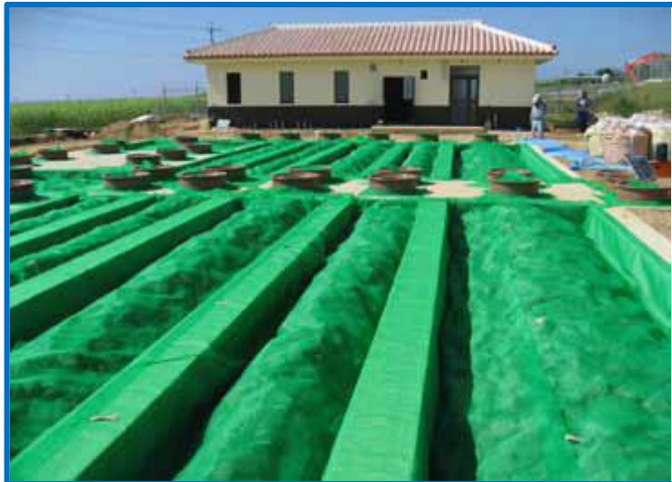
GRÁFICO N° 32 Instalación de la malla.
