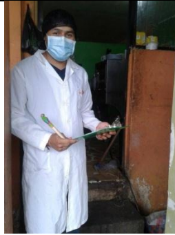
Figura 2. Paredes y pisos en mal estado. Restaurante “El Criollo”
