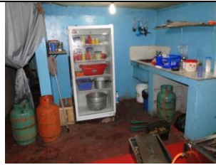
Figura 6. Paredes y pisos en mal estado, los tanques de gas no están debidamente guardados alto riesgo de accidentes, utensilios guardados en el refrigerados Restaurante “San Francisto”.
