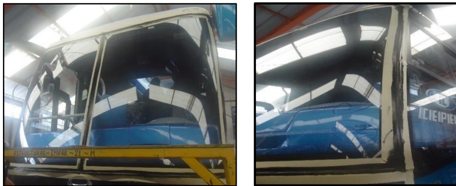
Fig. 44. Sellado de vidrios exteriormente
