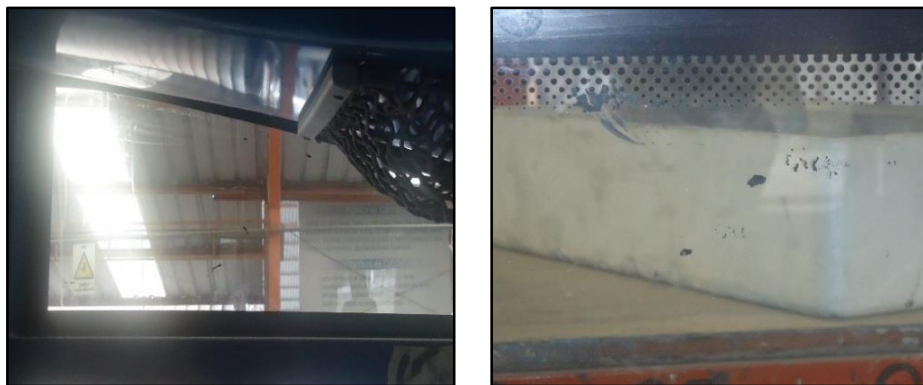
Fig. 45. Manchas de sikaflex en los vidrios del estribo
