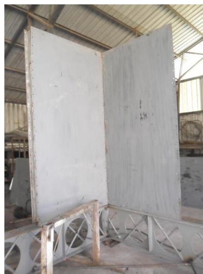
Figura N. 14 Construcción de paredes
