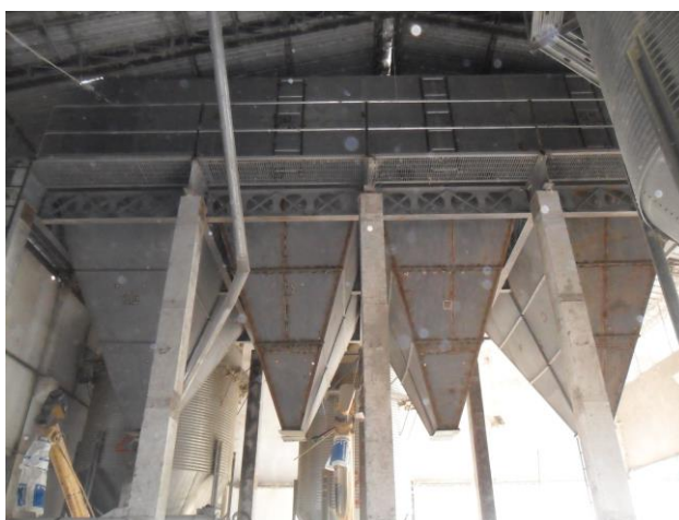
Figura N. 18 Pisos y escaleras
