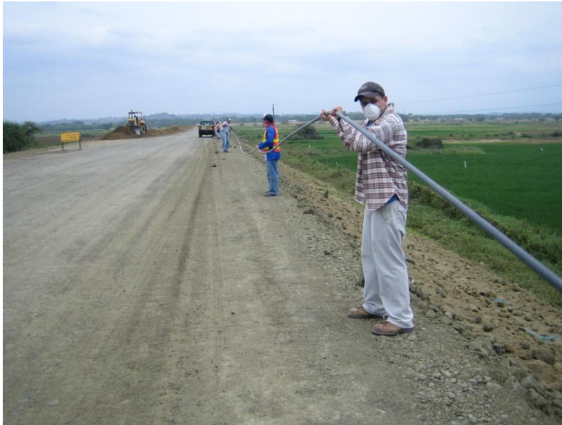
Foto No 30.- Colocación de cable transmisor de datos entre las tres secciones con un total de 6 piezómetros.
