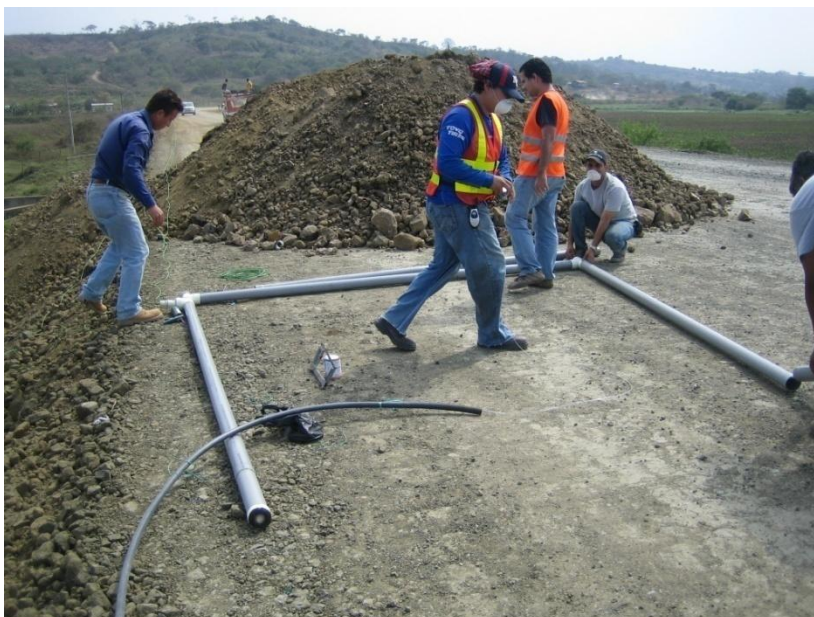
Foto No 29.- Armado del sistema de proteccion y colocacion de los piezometros en el extremo de la tuberia.
