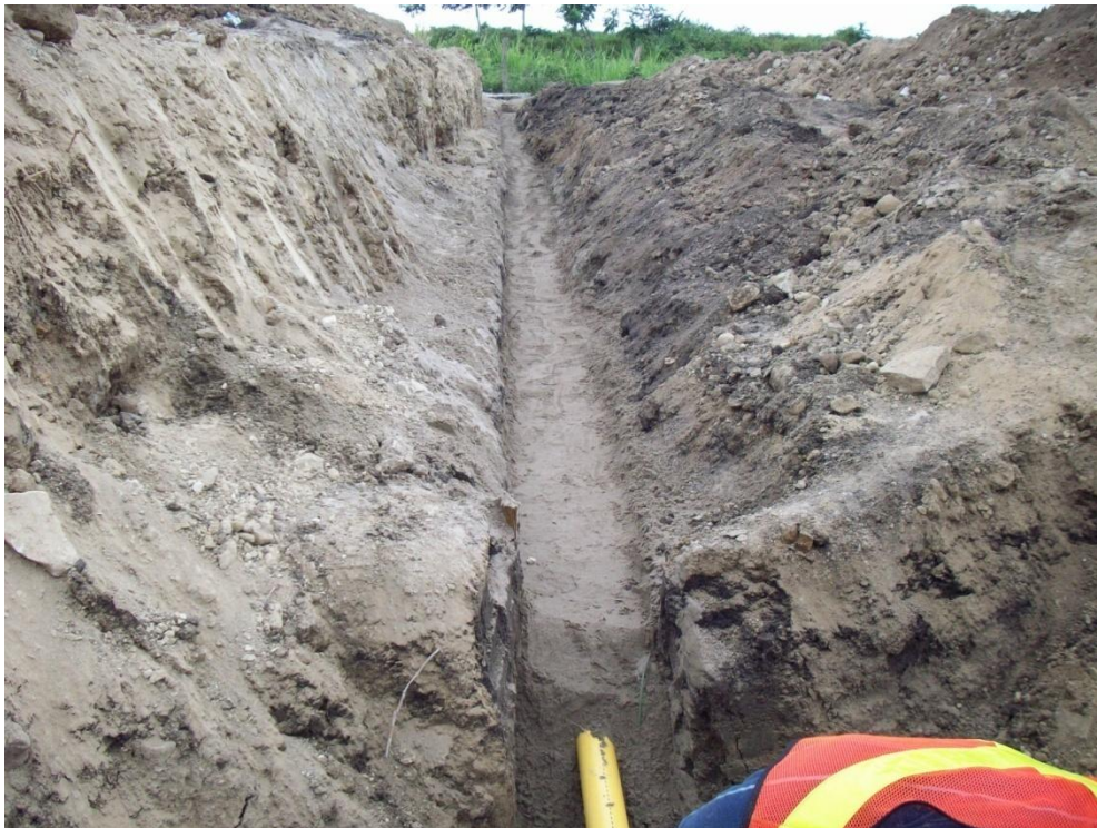
Foto 9.- Colocación de arena y tubería, controlado con niveles de precisión.
