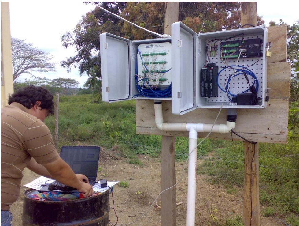
Foto 17.- Colocación de los Data Logger (Handi Logger). Para los almacenamientos de las lecturas de los inclinómetros.
