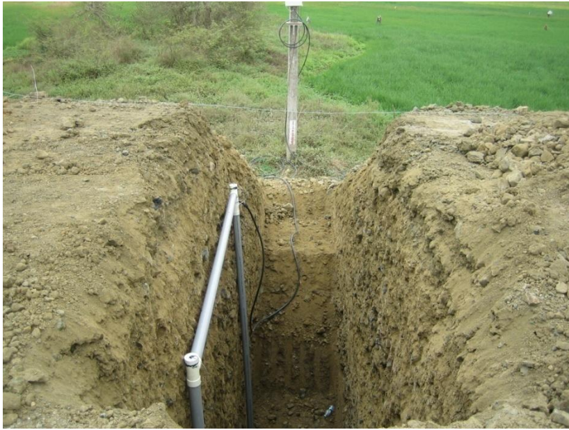
Foto No 34.- Instalación en la segunda sección. Km: 11+080
