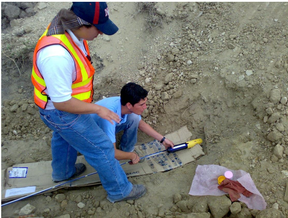
Foto 13.- Colocación de los inclinómetros dentro de la tuberías.
