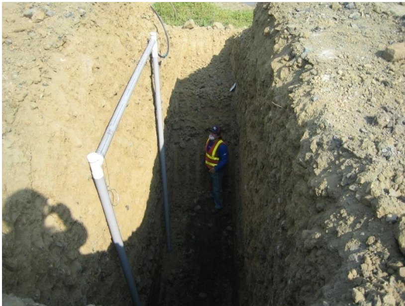
Foto No 31.- Instalación de los piezómetros en los sitios planificados, dos por cada sección.
