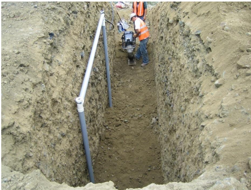
Foto No 35.- Instalación en la tercera sección Km: 11+230 y relleno de la zanjas con procedimientos controlados.
