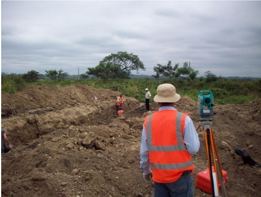
Foto 6.- Ubicación y replanteo de instalación (control dirección y niveles).
