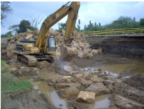
Excavación para mejorar el suelo de soporte y posterior relleno con materiales adecuados.
