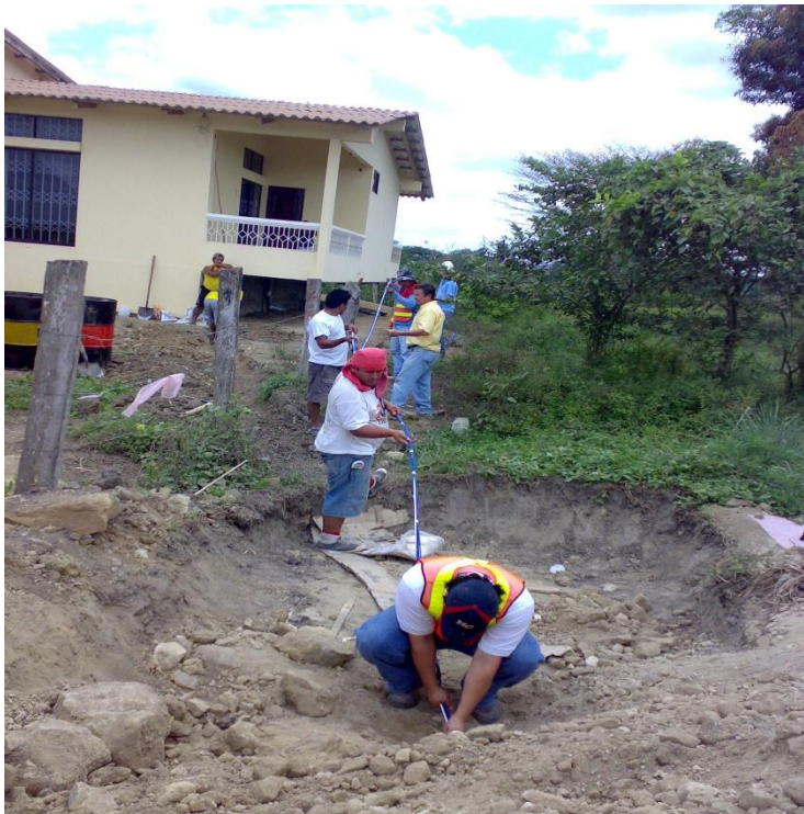
Foto 16.- Extracción de todo el sistema de inclinómetros verificando que las guías funciones bien.
