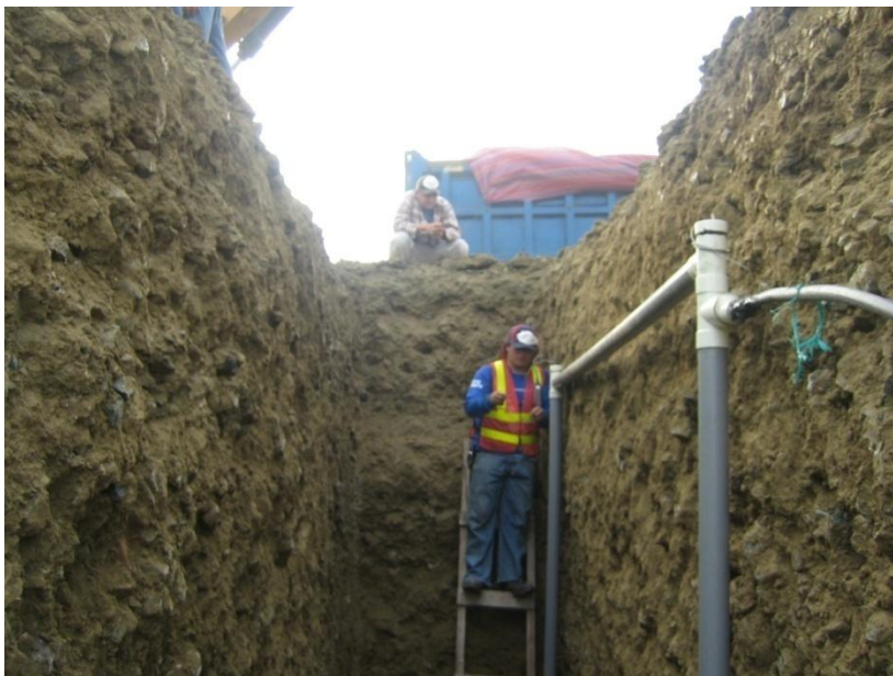
Foto No 33.- Instalación de los cables acerados que permitirán extraer los piezómetros después de su función.
