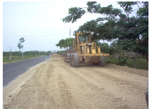
Excavación para mejorar el suelo de soporte y posterior relleno con materiales adecuados.
