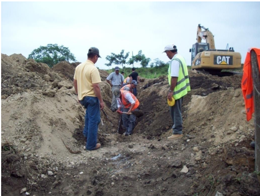
Foto 7.- Excavación de la zanja para el sistema de protección de la tubería.
