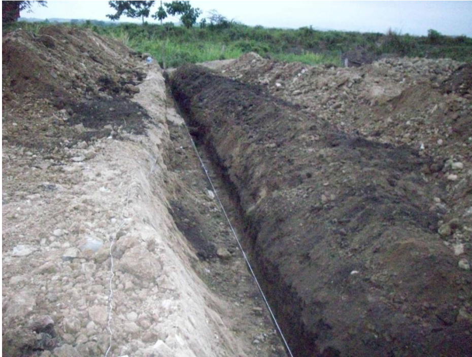
Foto 8.- Zanja lista para la instalación de los instrumentos.
