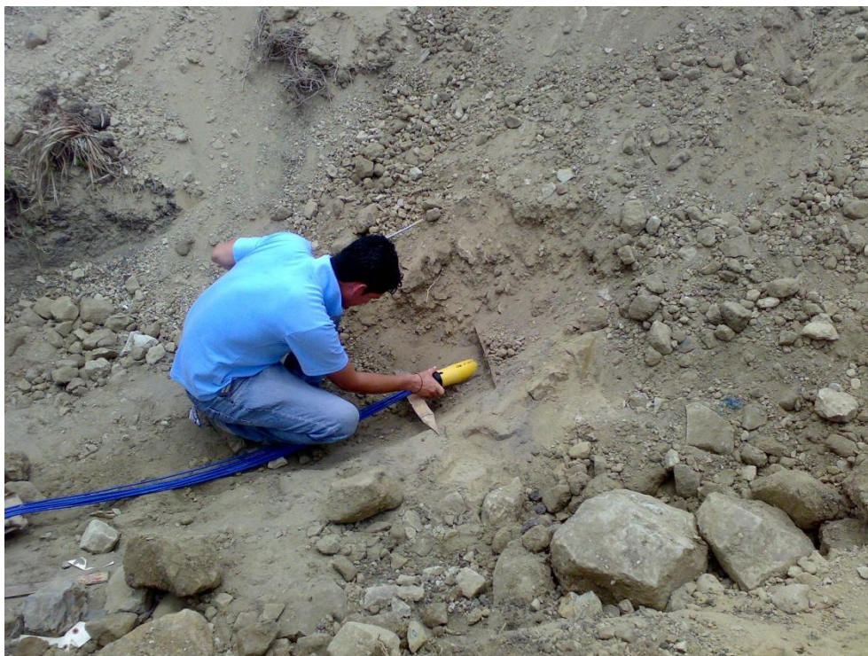
Foto 14.- Colocación de los inclinómetros dentro de las tuberías.
