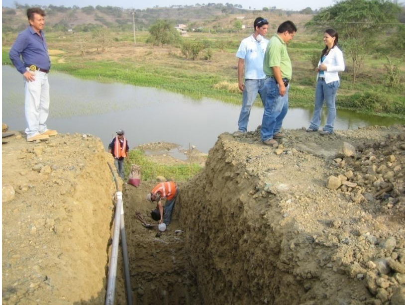
Foto No 33.- Instalación de los cables acerados que permitirán extraer los piezómetros después de su función.
