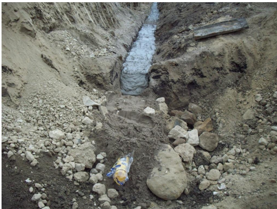
Foto 10.- Colocación de la pasta de cemento para la protección de tubería.
