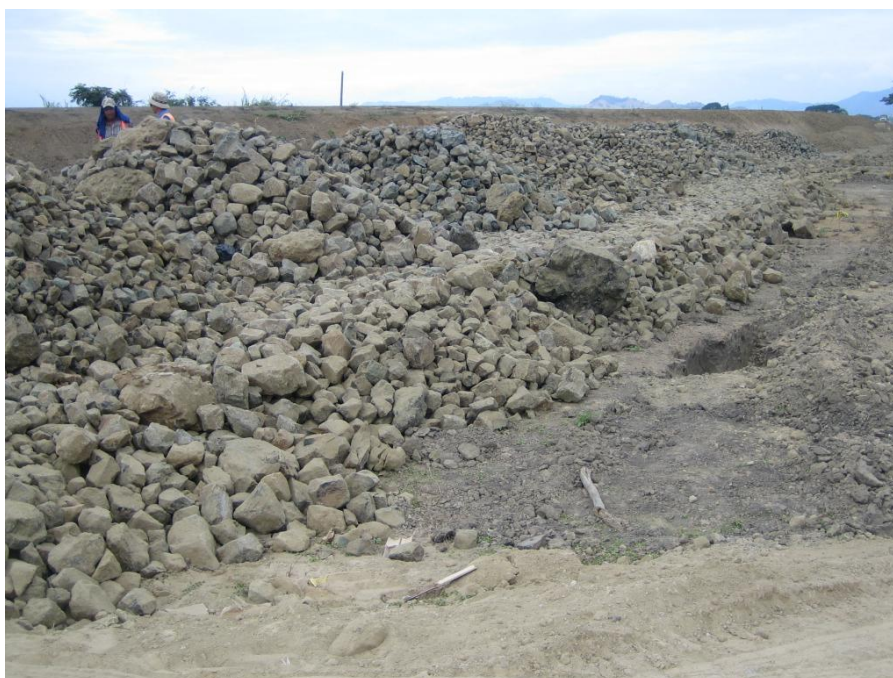
Foto 11.- Relleno de terraplén sobre inclinómetros.
