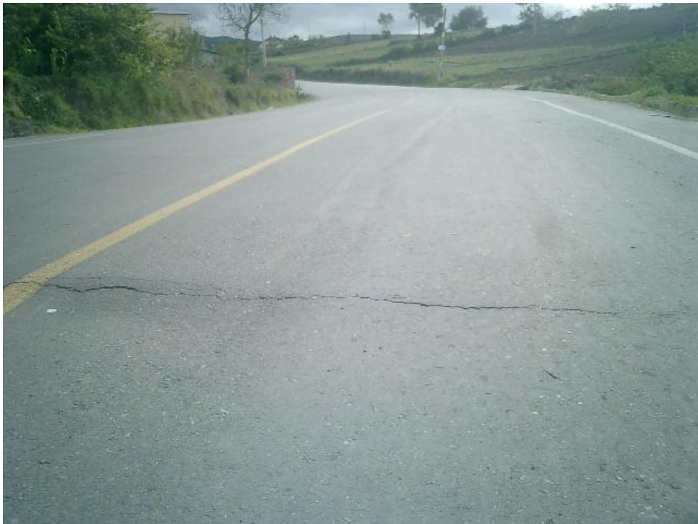
Fisura transversal
