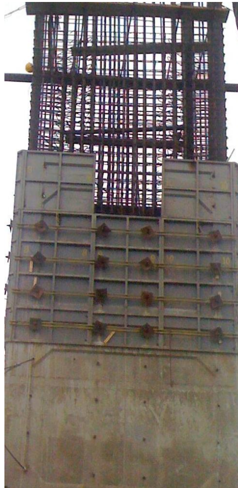
Montaje en la torre del puente Quevedo
