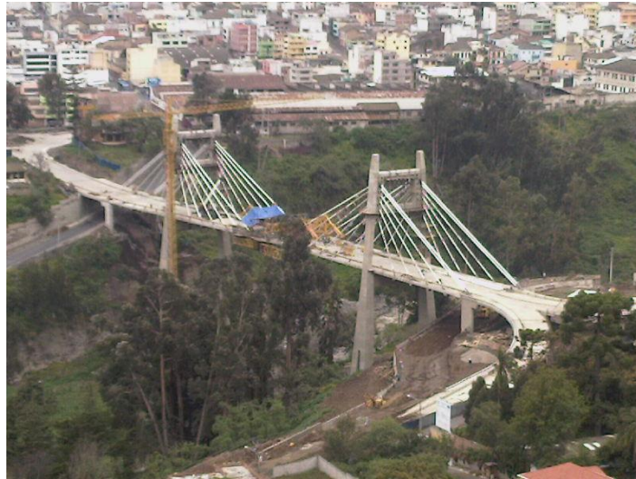
Ilustración 1: Fotografía del Puente Juan León Mera - Ambato
