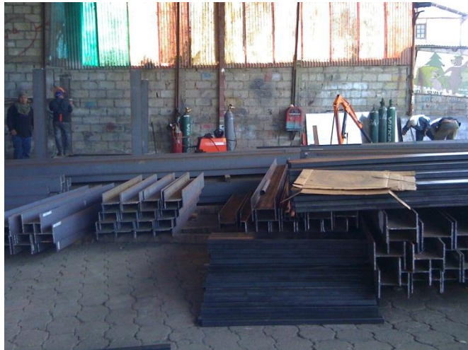
Mecánica Elaboración Encofrados
