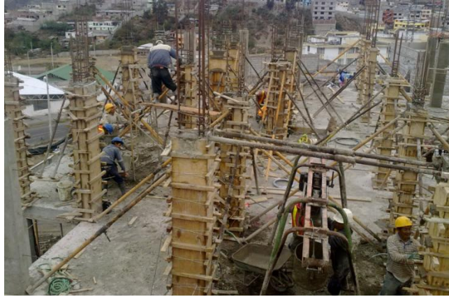
Encofrado de columnas
