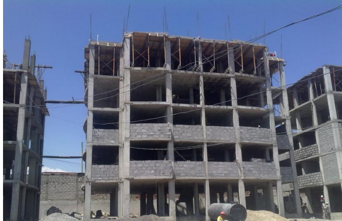
Encofrado de losas y vigas
