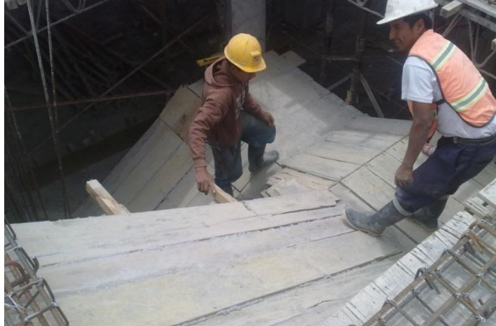
Encofrado de gradas
