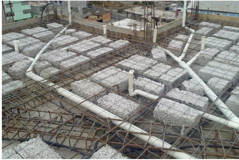
Malla electrosoldada en losas de cubierta
