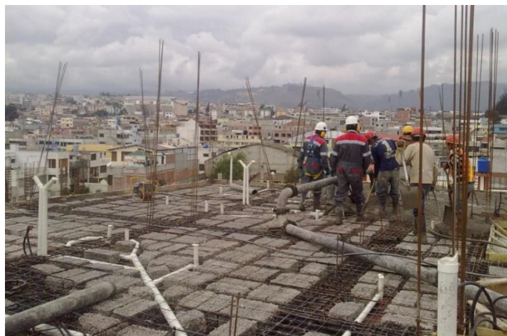
Hormigón en losas y vigas f'c=210 \text{ kg/cm}^2
