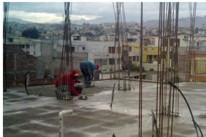
Masillado paletado sobre pisos Aditivo: Pozzolith 122 –HE
