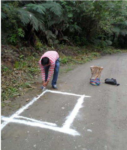
N°1: Trazado para excavación de suelo
