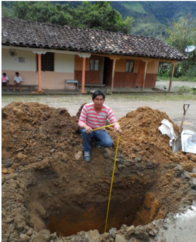
N°3: Profundidad de excavación
