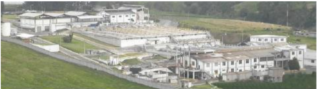
Vista panorámica de las instalaciones de PRODEGEL S.A.
