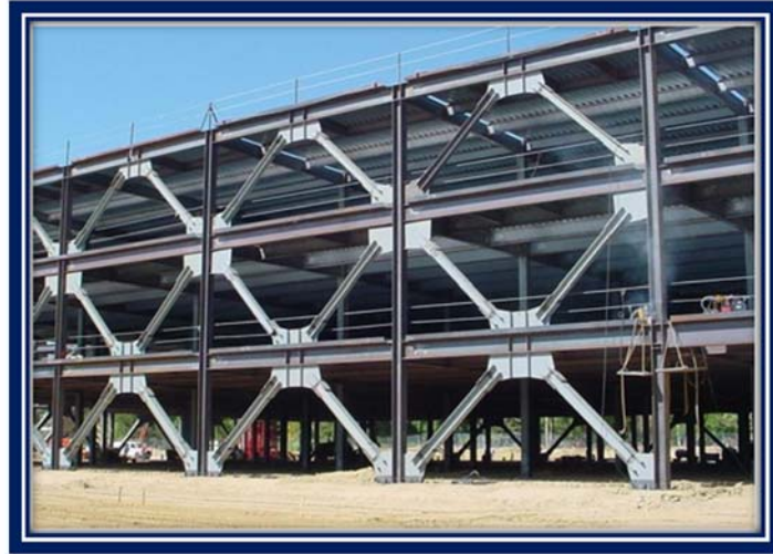
Gráfico II.4. Sistema de Pórticos con Diagonales Concéntricas
