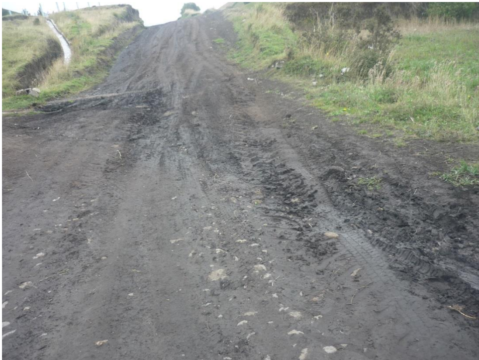
Vía empedrada – Vía de Tierra
