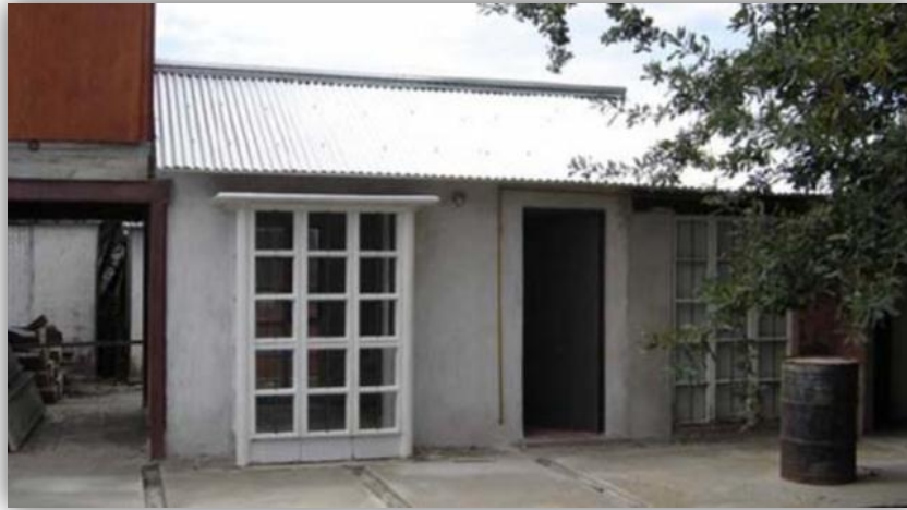
Ilustración 12: Vivienda construida en base a Ladrillos PET.
