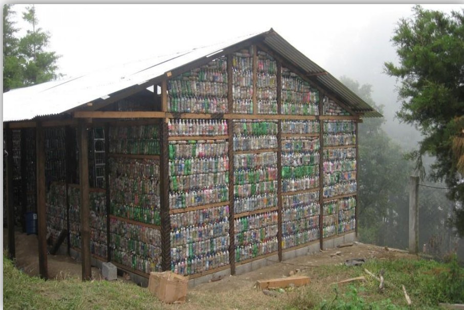
Ilustración 16: Paredes construidas con botellas de plástico
