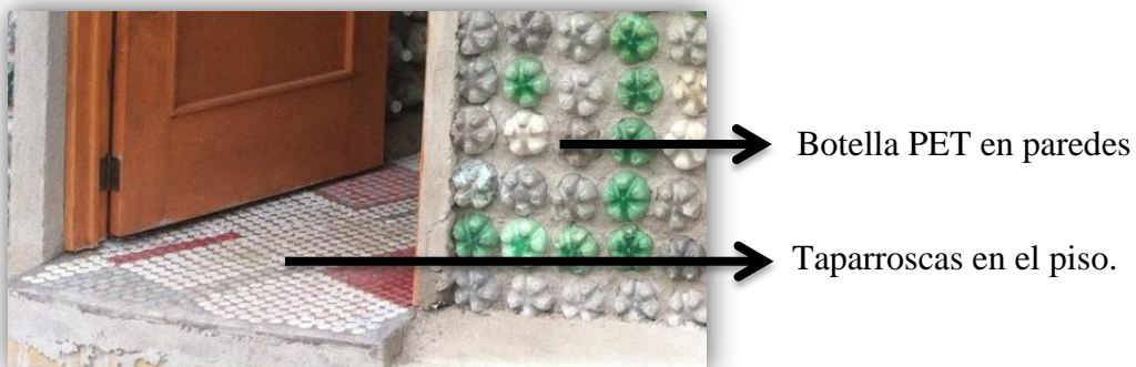
Ilustración 15: Paredes construidas con botellas de plástico
