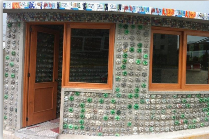
Ilustración 14: Paredes construidas con botellas de plástico
