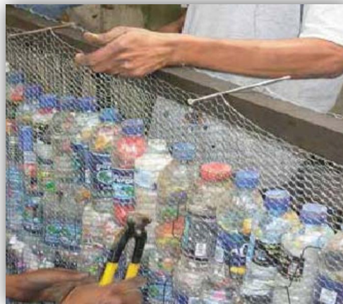
Ilustración 23: Colocación botellas plásticas
