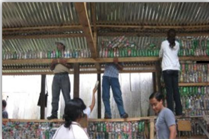
Ilustración 18: Colocación de las botellas dentro de la malla
