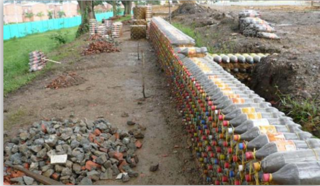
Ilustración 21: Muro de botellas plásticas
