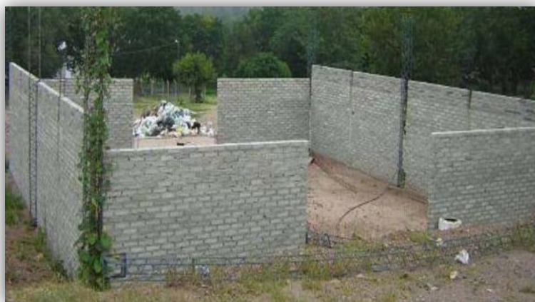
Ilustración 13: Muros galpón construidos en base a Ladrillos PET.
