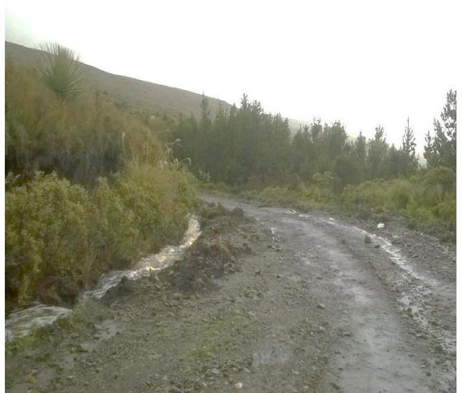
Ilustración 74: Canal situado al costado de la vía
