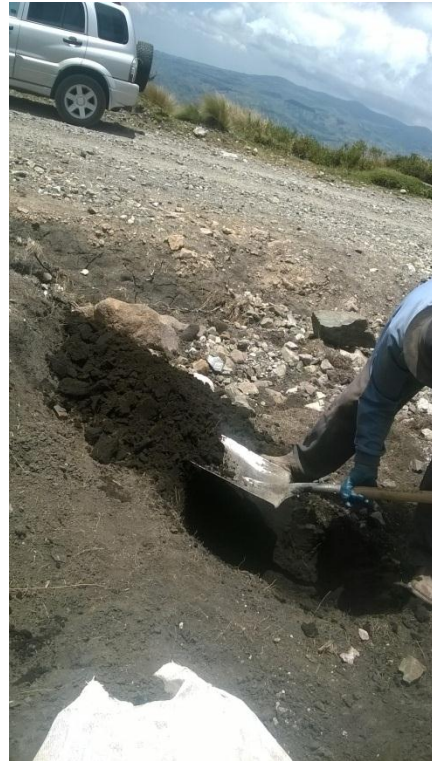
Ilustración 86 Retiro de Capa superior
