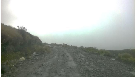
Ilustración 65: Lastrado de la vía
