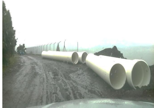
Ilustración 54: Trabajos con tubería
