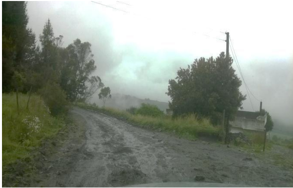
Ilustración 59: Estado actual de la vía
