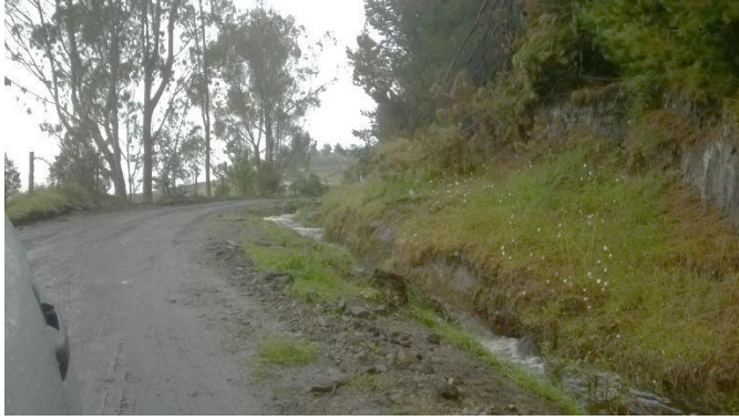
Ilustración 57: Tramos final de la vía
