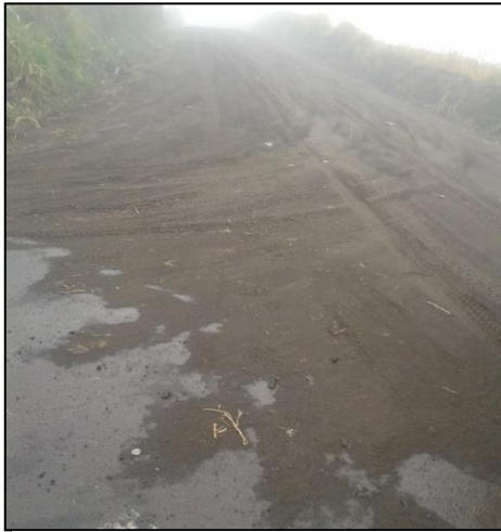
Inicio del proyecto Km 0+000 Comunidad de Jaloa Alto El Guasmo
