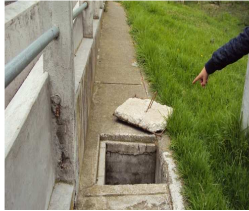
Caja de revisión abierta en los corrales
