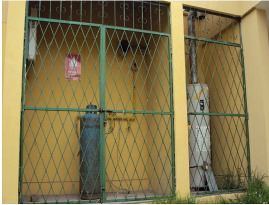
Señales en la zona de tanques de gas
