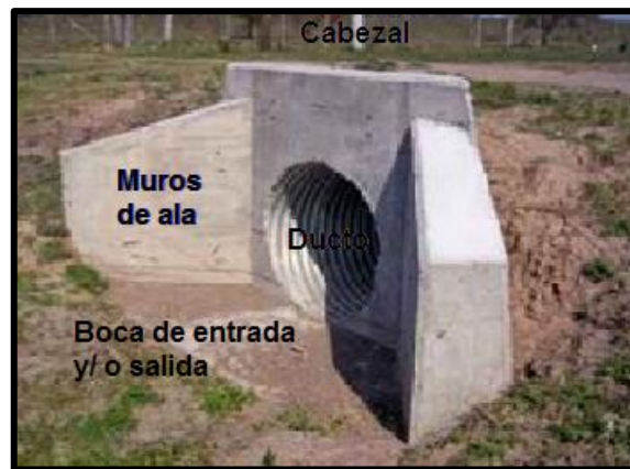
Gráfico N. 18 Elementos de una alcantarilla
