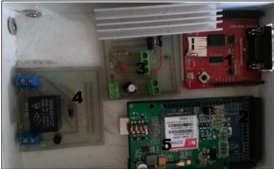
Fig. 4.32 Módulos electrónicos para la implementación del prototipo del sistema de control y monitoreo
