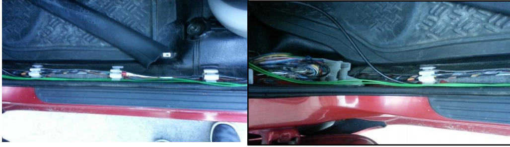
Fig. 4.43 Canaleado del cableado externo del sistema en el vehículo Elaborado por: David Chávez
