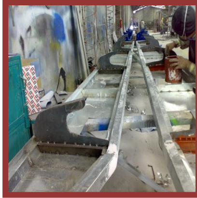
Cortar y doblar plancha 1/25 Pulg. para la construcción de las canastillas.
