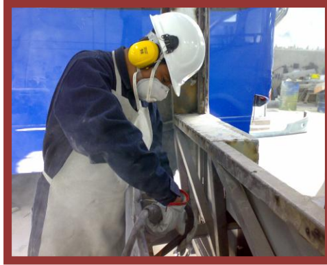
Pulir estructura de frente y posterior
