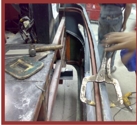
Pegar y remachar estructura de guarda choque con pieza de fibra de vidrio de la misma.
