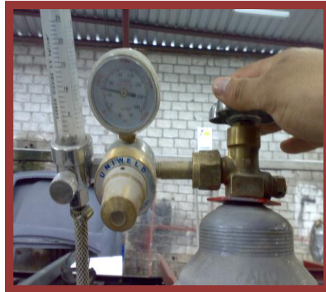
Regular válvula de salida de gas CO 2 .
