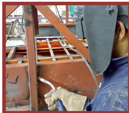
Empezar a rematar la estructura haciendo cordones de +/- 5 cm de longitud así como también una excelente penetración, según normas de la EMSAT.
