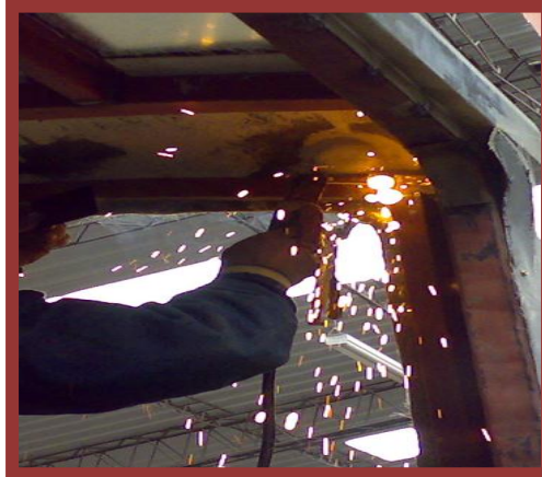
Construir estructura de mascarilla con tubo cuadrado de 3/4 x 1.5 Pulg.
