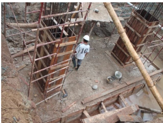
Fig. N° 55. ENCOFRADO
