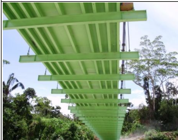
Armado de vigas longitudinales
