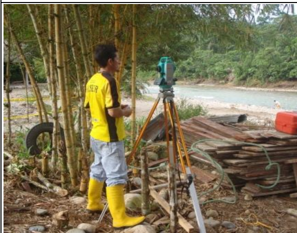
Replanteo y Nivelación
