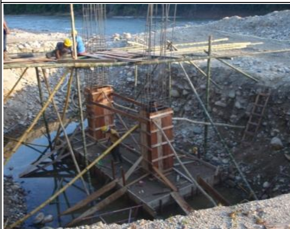
Hormigón simple en torres
