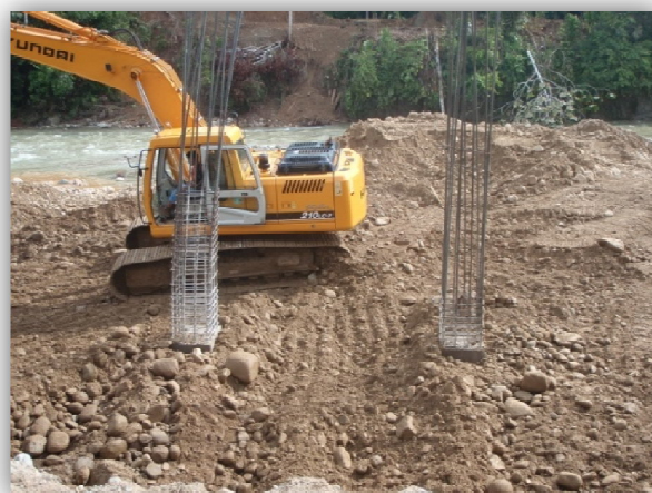
Fig. N° 50 RELLENO CON MAQUINA.
