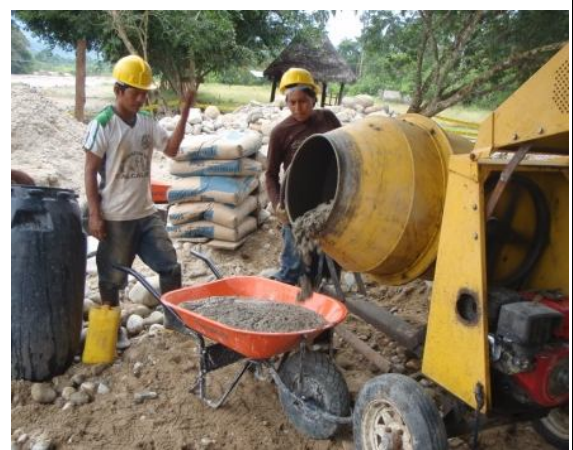
Preparación del Hormigón
