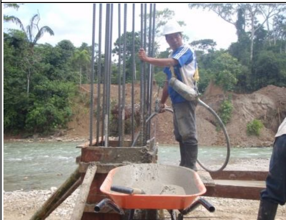
Colocación del Hormigón
