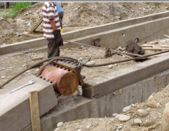
Colocación del cable en Anclajes
