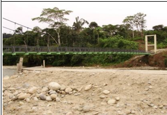
Acabado del puente
