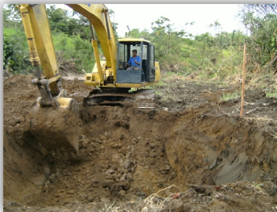
Fig. N° 51. EXCAVACIÓN MECÁNICA SIN CLASIFICAR.
