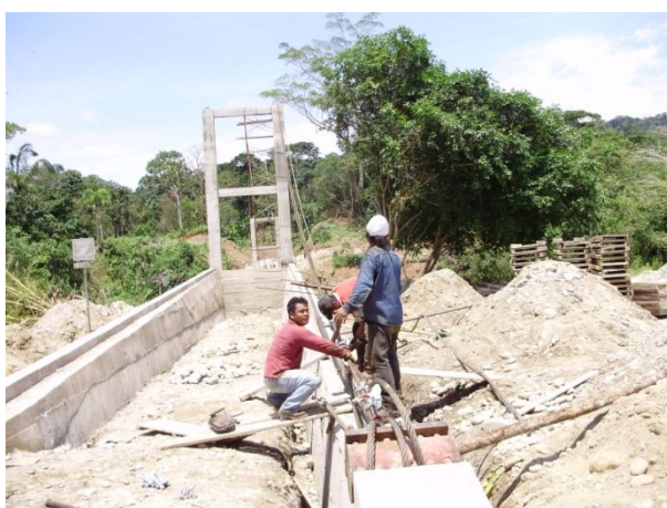
Fig. N° 57. TENSADO DEL CABLE
