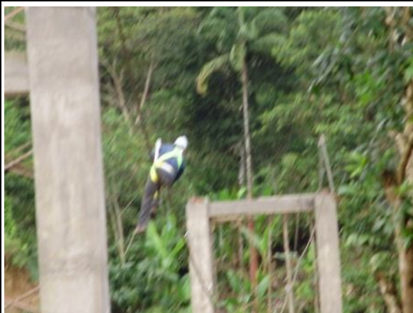
Colocación de Péndolas
