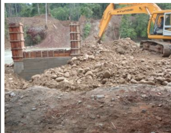
Relleno con material natural
