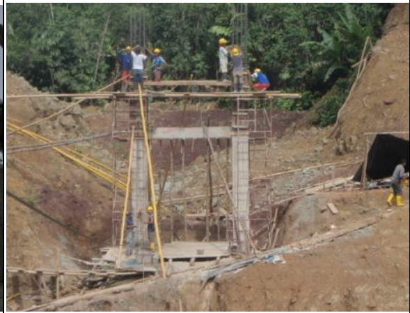
Encofrado 2do nivel de torres
