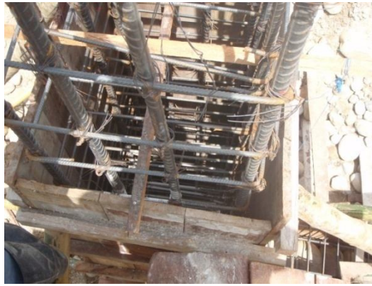
Fig. N° 59 ACERO DE REFUERZO.
