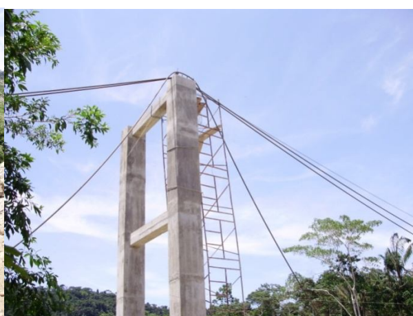
Fig. N° 58. CRUCE DEL CABLE
