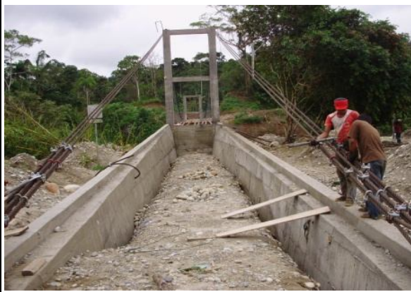
Tensado de Cables
