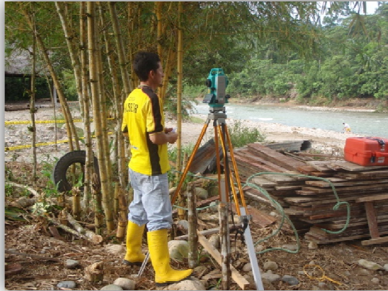
Fig. N° 46 REPLANTEO Y NIVELACION
