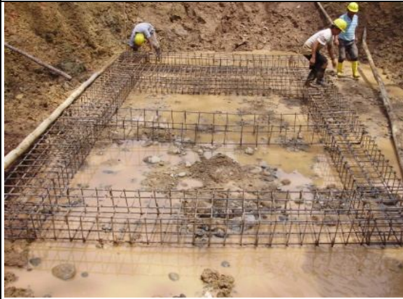
Armado de Anclajes
