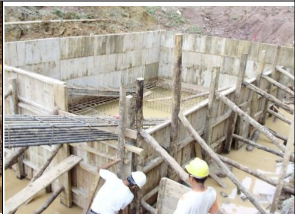
Encofrado de Anclajes
