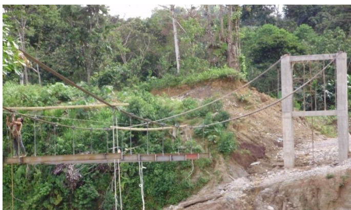
Fig. N° 65. COLOCACIÓN DE PÉNDOLAS
