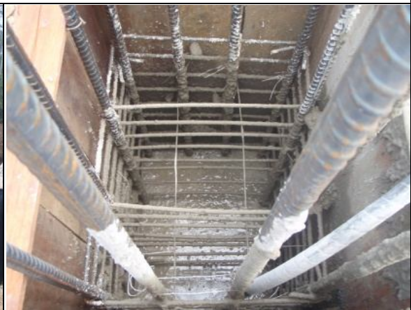
Armado de columna
