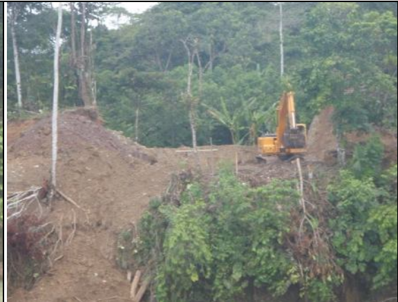
Limpieza mecánica del terreno
