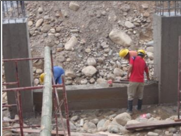
Terminación de torre 1er nivel
