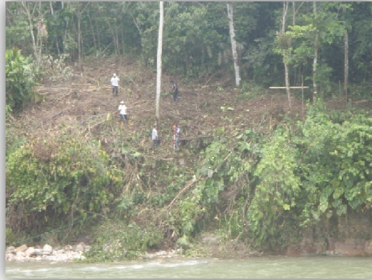
Fig. N° 45 LIMPIEZA MANUAL DEL TERRENO.
