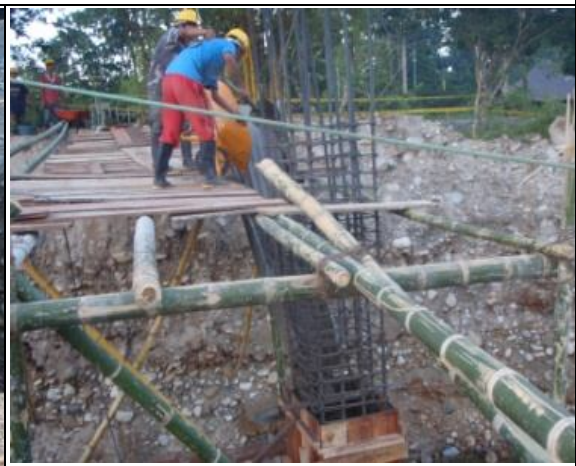
Acero de refuerzo en torres
