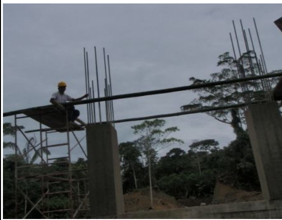
Armado de torres
