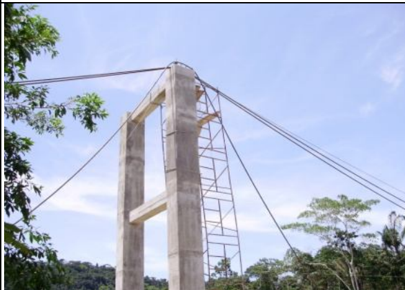
Colocación de cables en Galápagos
