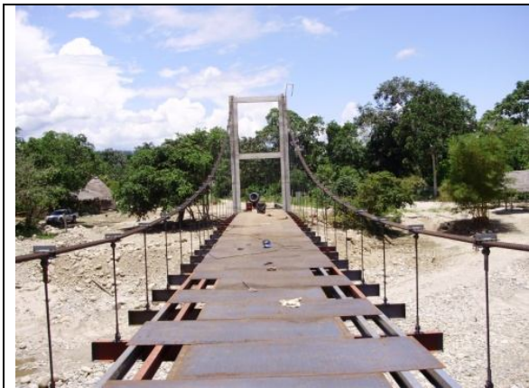
Colocación de tool corrugado
