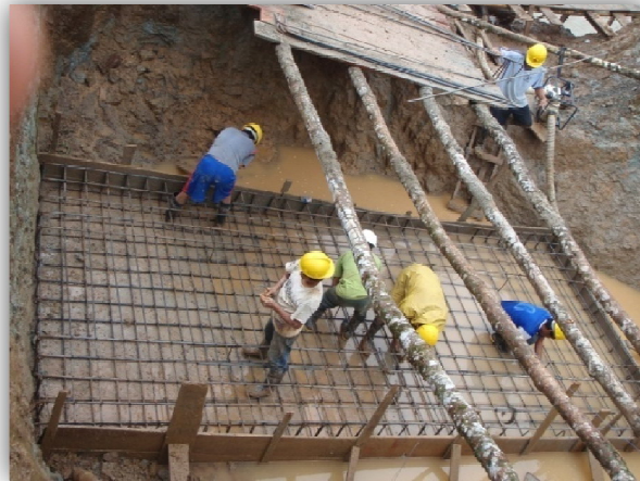
Fig. N° 52. REPLANTILLO DE HORMIGON SIMPLE F'c = 180 \text{ kg/cm}^2
