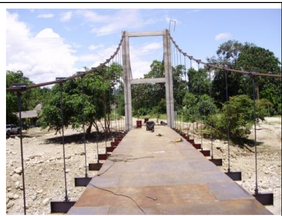
Armado del tablero
