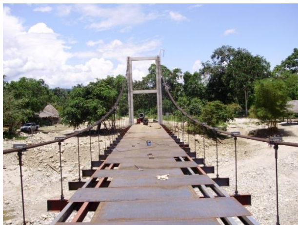
Fig. N° 60. ARMADO DEL TABLERO
