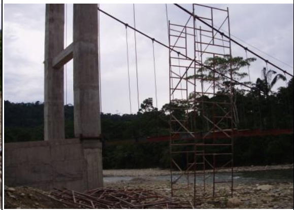
Colocación de Péndolas
