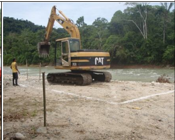
Limpieza mecánica del terreno
