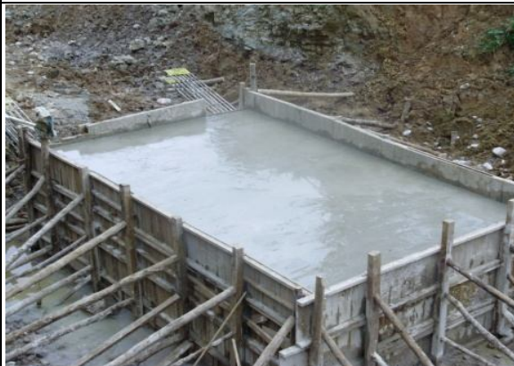
Fundición de Anclajes
