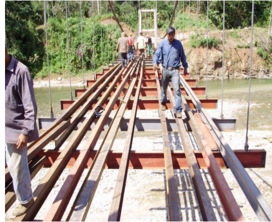
Fig. N° 62 VIGAS LONGITUDINALES.
