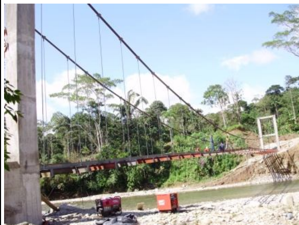
Colocación de vigas
