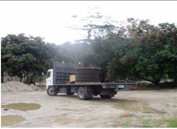
Llegada del cable enrollado
