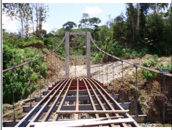
Colocación de vigas longitudinales
