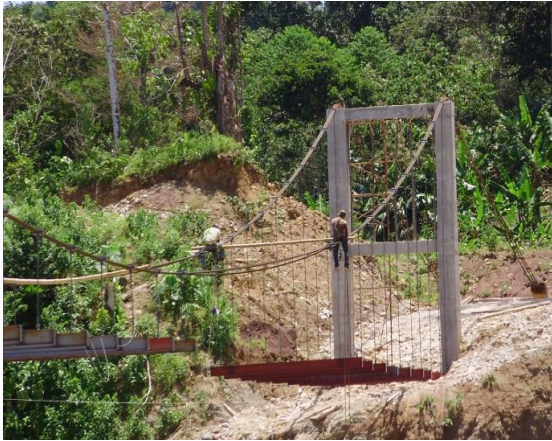
Fig. N° 61. VIGAS TRANSVERSALES
