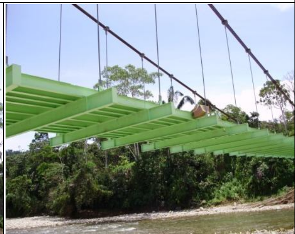
Armado de vigas transversales
