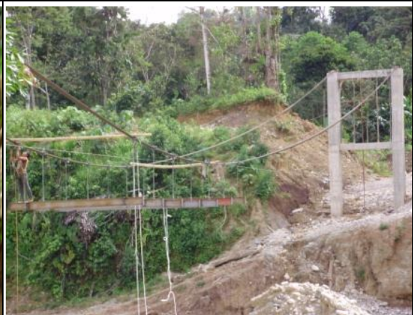
colocación de vigas transversales IPN
