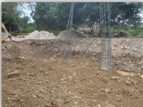
Fig. N°49. RELLENO COMPACTADO CON SUELO NATURAL
