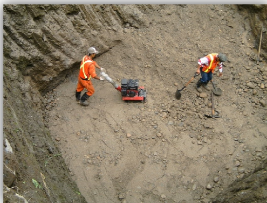
Fig. N° 48. EXCAVACION A MANO
