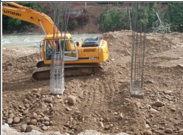
Relleno compactado con suelo natural
