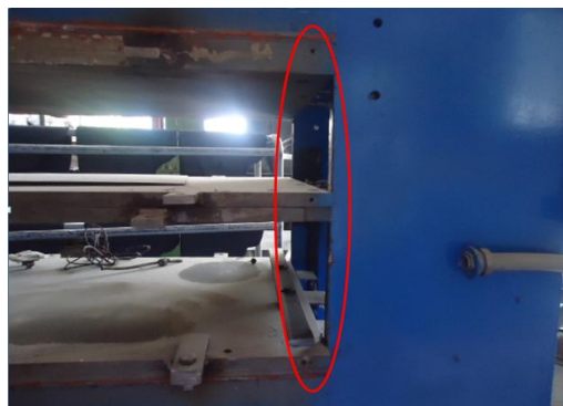
Figura 6.24 Conexión de las Termocuplas tipo J
