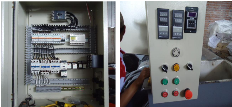
Figura 6.18 Montaje de la Caja de Control
