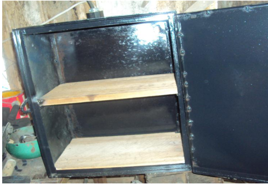
Imagen 9 Vista Interior Caja de Control Fuente: Egdo Daniel Núñez
