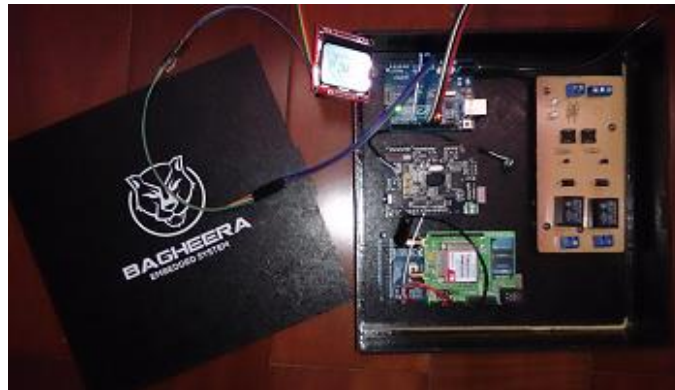
Figura 4.38: Prototipo instalado en la caja Fuente: El Investigador.
